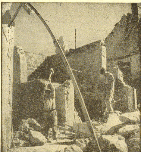
Vercors: Zuerst müssen die Trümmer weggeschafft werden. Vercors: Il faut d'abord déblayer.
