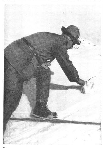
Wo gefahrloser Antritt zu Lawinenhängen möglich ist, kann die Loslösung der Schneemasse durch mit Sprengstoff geladene Blechbüchsen herbeigeführt werden.
