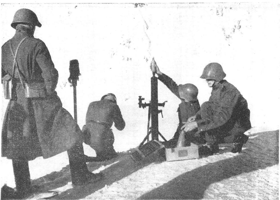
Beschuss eines Lawinenhangs mittelst Minenwerfer.
