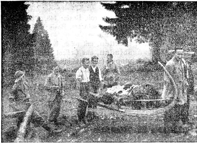
Als ein sehr zweckmässiges Transportmittel hat sich der Walder-Hornschlitten für den Gebirgstransport erwiesen. Polsterung ist leicht anzubringen, ebenso Tragstangen hinten. Bergan trägt ihn ein Mann auf dem Rücken; talwärts wird geschüttelt, gezogen oder getragen.
