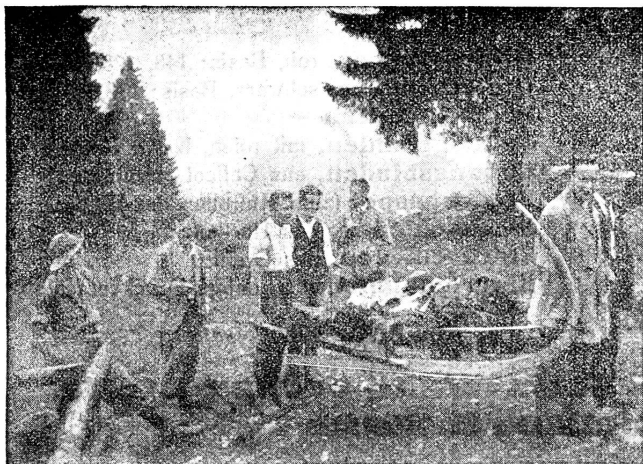
Als ein sehr zweckmässiges Transportmittel hat sich der Walder-Hornschlitten für den Gebirgstransport erwiesen. Polsterung ist leicht anzubringen, ebenso Tragstangen hinten. Bergan trägt ihn ein Mann auf dem Rücken; talwärts wird geschüttelt, gezogen oder getragen.
