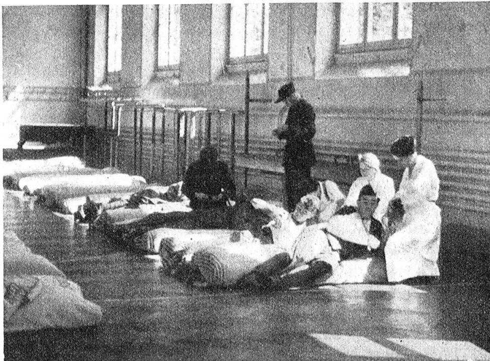
Errichtung eines Hilfsspitals durch Rotkreuzkolonnen und Samariter.
