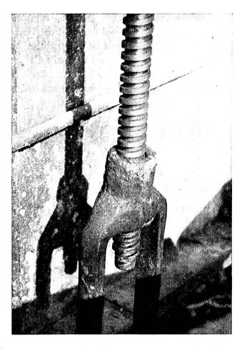
La vis sans écrou d'arrêt qui va provoquer l'accident.
