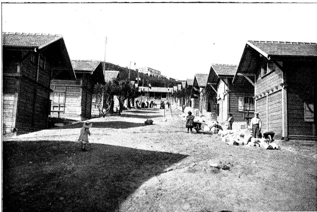
Schweizerdorf Meßina. — Kanalisationsarbeiten.
