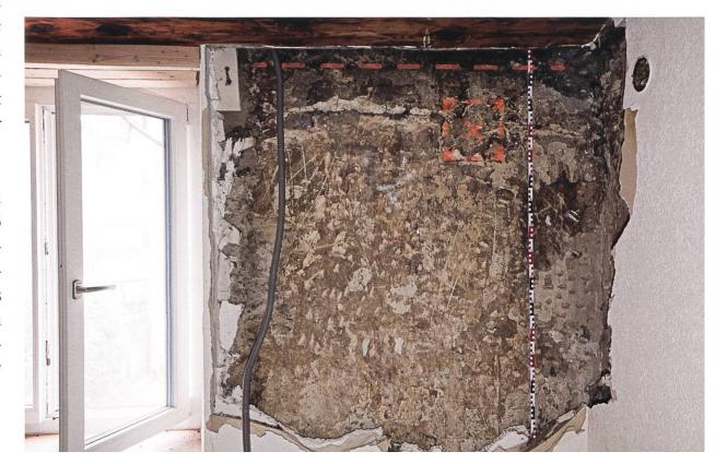
Baualtersplan der südlichen Giebelwand, in der sich der flachgieblige Ursprungsbau (rot) deutlich abzeichnet. Eine sehr ähnliche Dachkonstruktion, per Jahrringanalyse nur drei Jahre jünger datiert, wurde 2019 in einem Gebäude in der Altstadt von Laufen dokumentiert. Beim Bauernhaus in Wahlen war der Südgiebel mindestens im dritten und eventuell auch im zweiten Dachgeschoss verbrettert, was noch an einer Nut an der Unterseite des südlichs-
