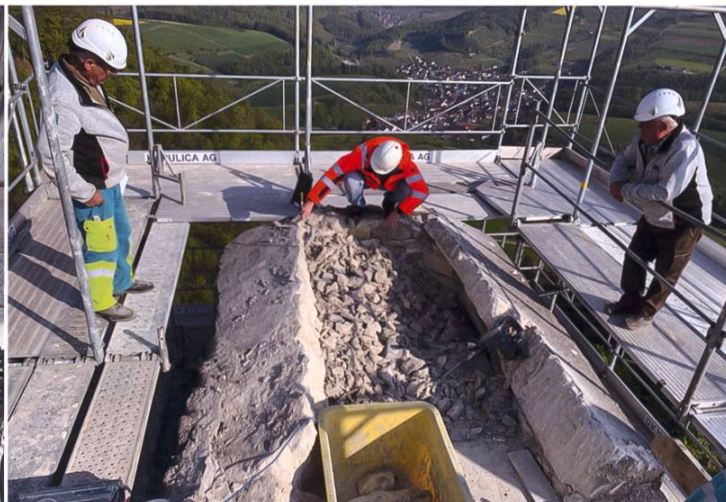
Das aufgespitzte Rundgewölbe über der Wendeltreppe in der Schildmauer: Ingenieur Manuel Wieland nimmt Mass für die geplante Ersatzkonstruktion.
