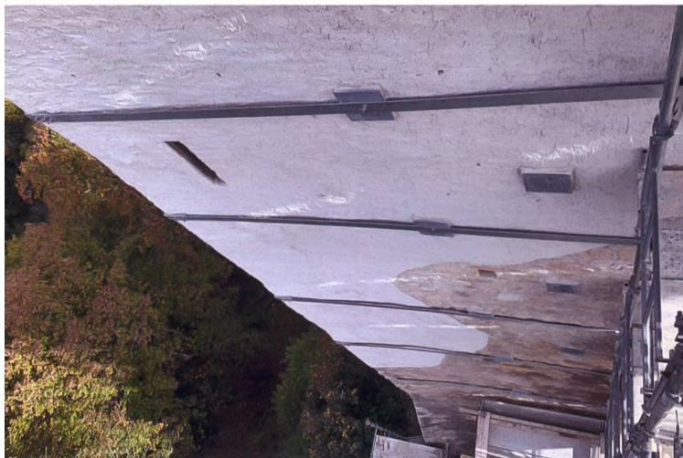
Die frisch sanierte Westflanke der Schildmauer mit den neu angebrachten Stahlklammern und Zugankern.
