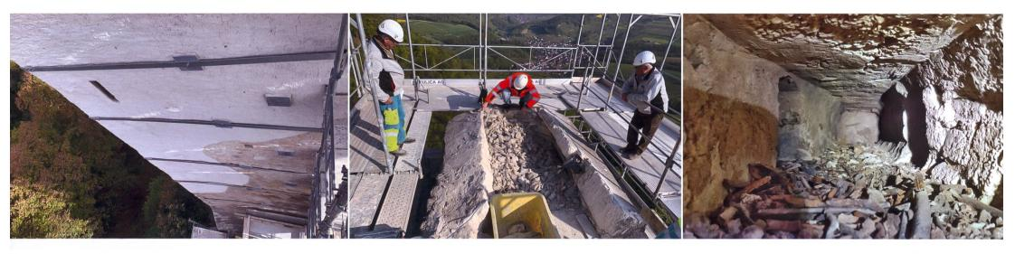
Die frisch sanierte Westflanke der Schildmauer mit den neu angebrachten Stahlklammern und Zugankern.
