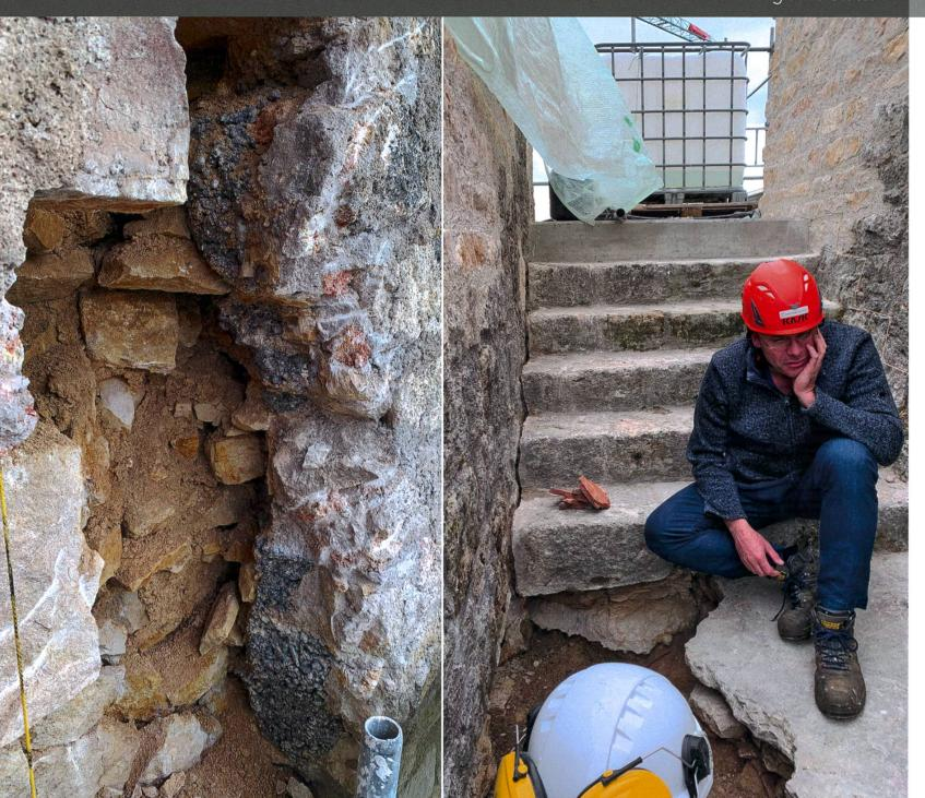
Gravierende und unerwartete Schäden bis zuletzt: Hinter einer in den 1950er Jahren neu aufgebauten Schale an der Schildmauer kommt der verwitterte burgenzeitliche Mauerkern zum Vorschein. Die beiden Mauerteile sind nicht miteinander verbunden (links).
