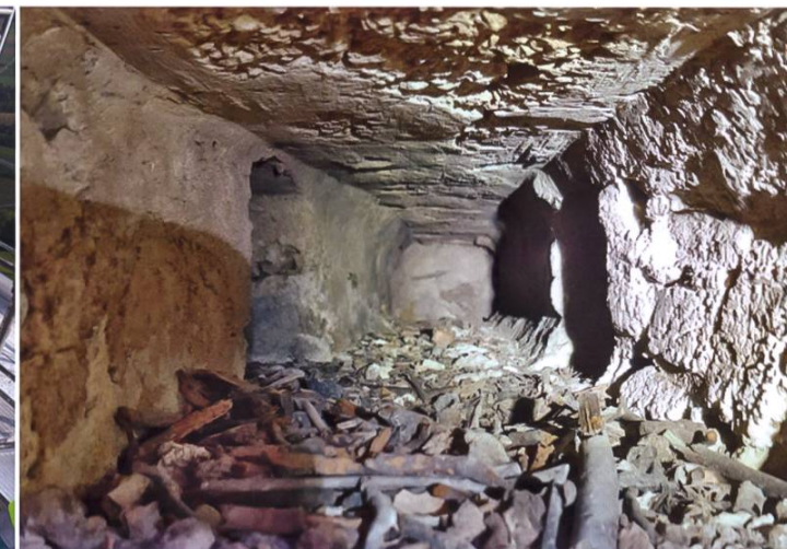
Blick in ein Pharaonengrab? Nein, aber nicht weniger spannend: Die Negative des Balkenrostes im Innern der Schildmauer, der als Verstrebung diente.
