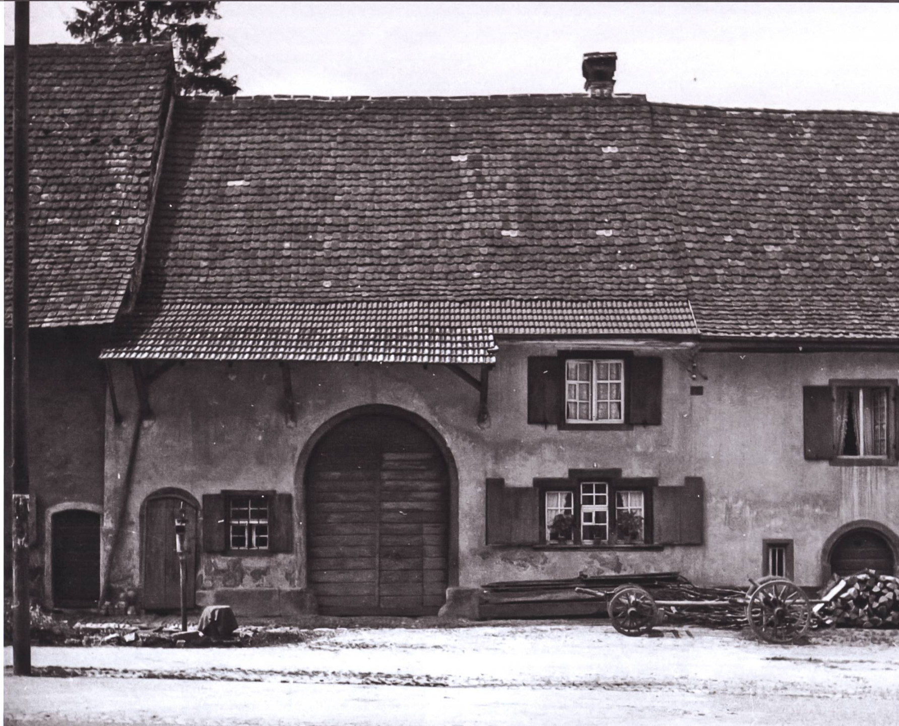
Muttenz, Oberdorf 4 vor dem Umbau zum Museum (Kantonale Denkmalpflege).
