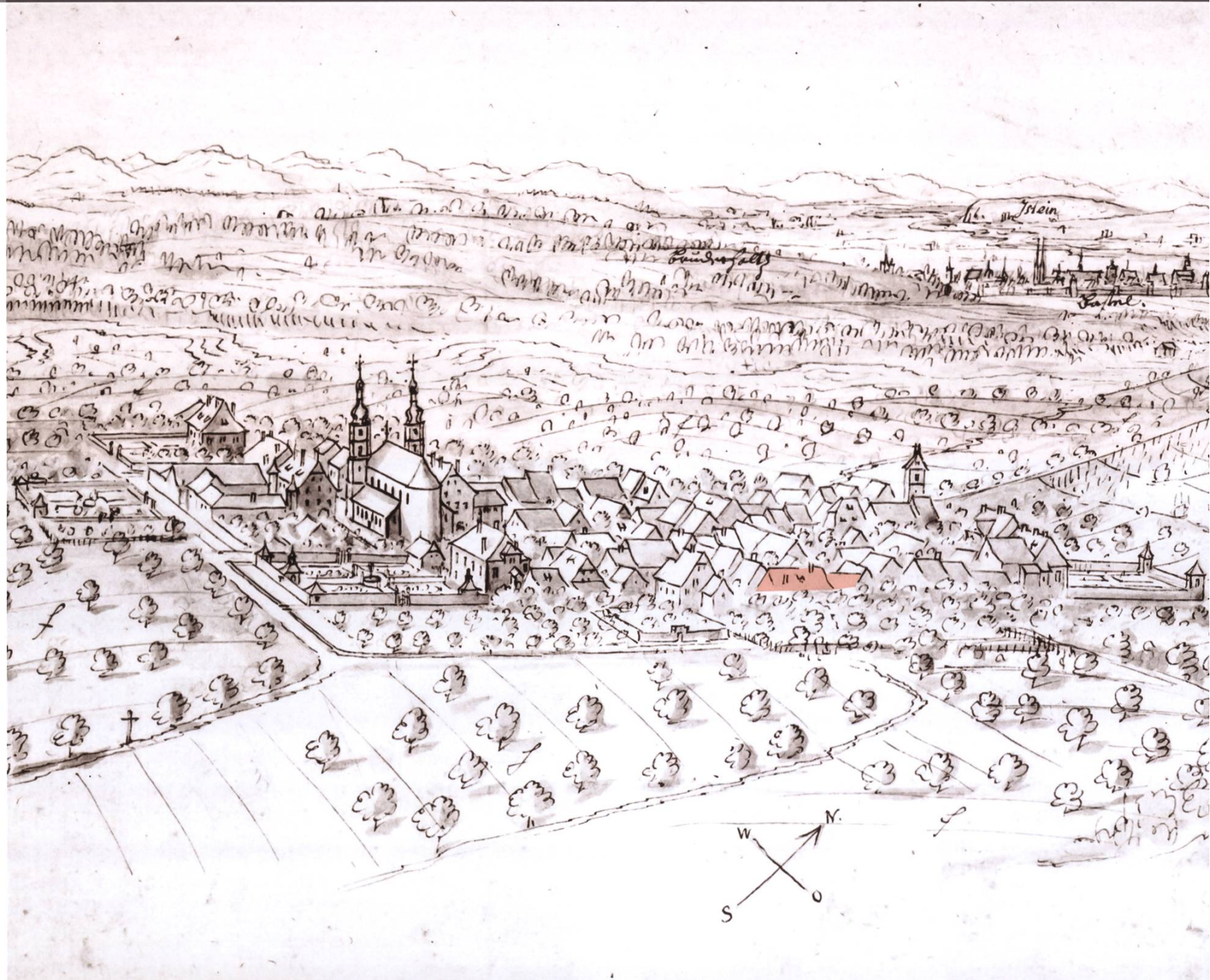
Arlesheim, Obere Gasse 14. Auf der Dorfansicht von Emanuel Büchel aus dem Jahr 1754 ist der Gebäudekomplex ansatzweise zu erkennen.
