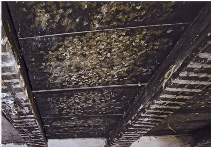
Weisse Tupfen auf schwarzem Untergrund als Deckenbemalung der Stube im Erdgeschoss des Wohnhauses von 1695 (d).
