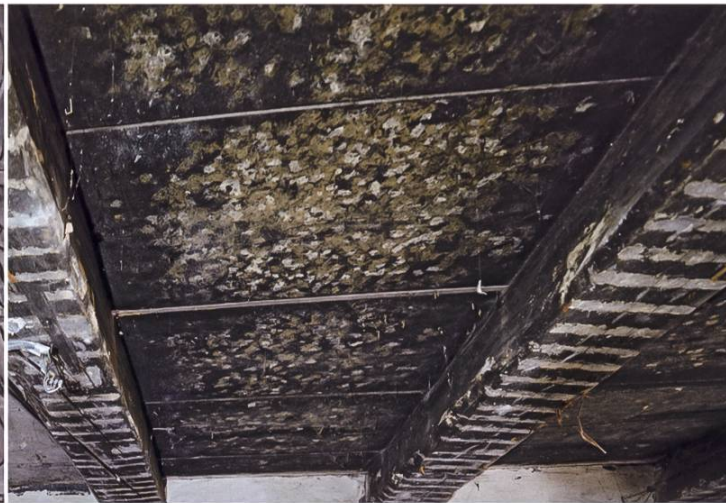
Weisse Tupfen auf schwarzem Untergrund als Deckenbemalung der Stube im Erdgeschoss des Wohnhauses von 1695 (d).
