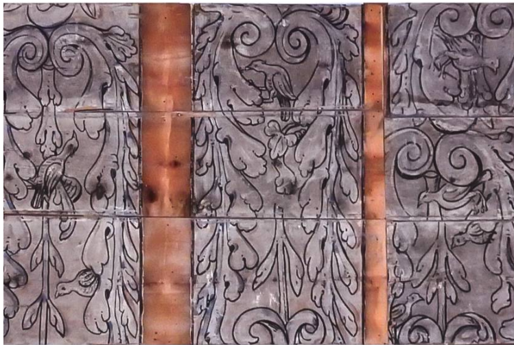
Die ehemaligen Deckenbretter der floral verzierten Stube im Obergeschoss des Wohnhauses von 1695 (d).
