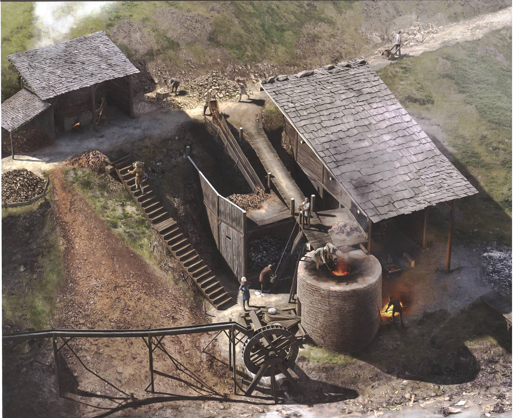
Langenbruck, Dürstel. Rekonstruktion des Verhüttungsplatzes mit dem Hochofen aus dem 13. Jahrhundert (Joe Rohrer, Luzern).
