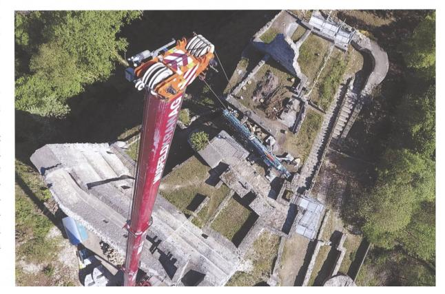
Das fertig sanierte Brunnenhaus. Links oben die Vormauerung aus Gisibergsteinen als Felsschutz und neues Habitat für Flora und Fauna. durch eine Solarstromanlage generiert, was für die Region Basel ein Novum bedeutet.
