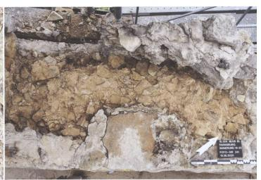
Schadensbilder, wie sie für die Farnsburg typisch sind: Die Innenwand des Blauen Turms nach Entfernung der frostzerstörten Mauersteine (ProSpect GmbH).
