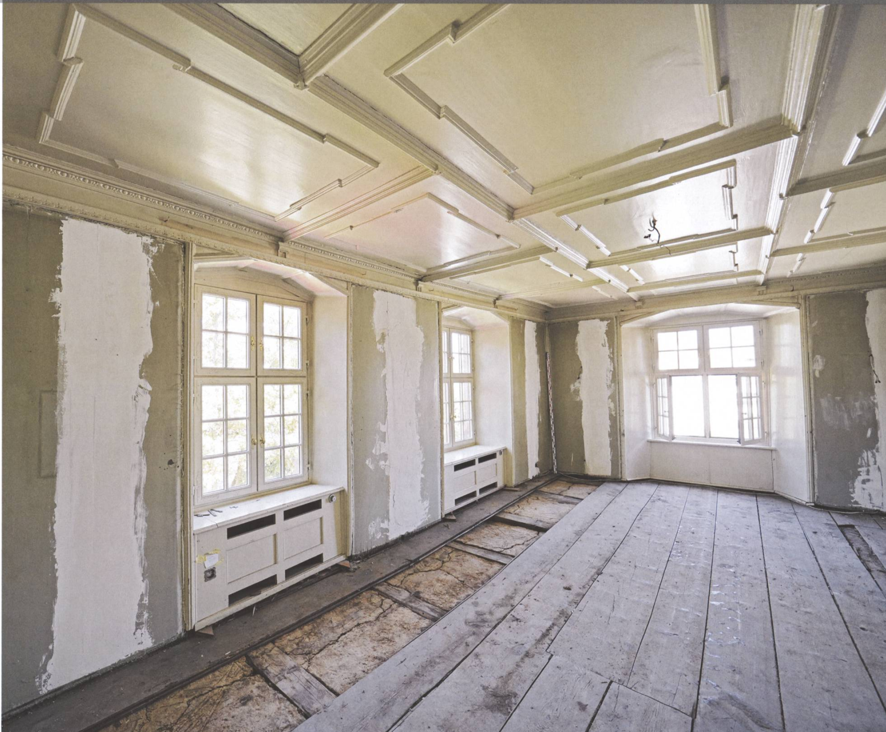
Binningen, Schlossgasse 5 (Schloss). Der Saal im ersten Obergeschoss nach Entfernung der modernen Oberflächen an Wänden und Böden.
