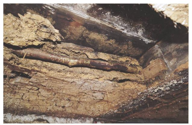
nun sichtbaren Bodenbalken Proben für eine Dendrodatierung entnommen. Des Weiteren war erkennbar, dass der Lehmestrich auf die Bretter des Schiebbodens aufgebracht wurde, die in einer Nut in den Balken liegen.
