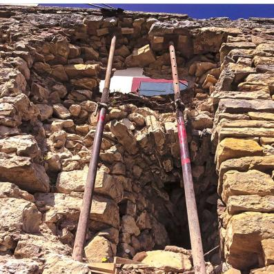
abgebrochen und neu aufgebaut, die restlichen Mauern mit Dutzenden Mauerankern gesichert und frisch verfugt werden. Mauerkronen und Terrassenflächen werden aufwändig abgedichtet und das Mauerwerk drainiert. Zuvor ist insbesondere das originale Mauerwerk einer eingehenden bauarchäologischen Dokumentation zu unterziehen.
