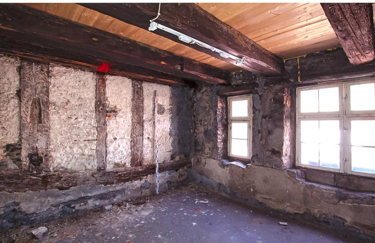
wändigen Konstruktion horizontal unterteilt. Der Dachstuhl besteht aus Nadelhölzern, die im Jahr 1662/63 geschlagen wurden.
