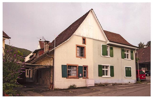
Möglicherweise wurden sie nass gelagert, denn zwischen den Wandständern und der Bruchstein-Ausfachung sind Schwundrisse zu erkennen.
