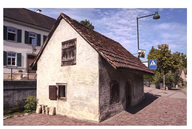
Der Südostgiebel ist mit einem kleinen Fenster zum Schlachtraum hin sowie einem darüber liegenden Zugang zum Dachraum ausgestattet. Der Nordwestgiebel ist heute fensterlos, wies einst aber zwei Öffnungen auf, die beim Umbau im 19. Jahrhundert zugesetzt wurden. Um dennoch genügend Licht im Innern zu haben, vergrösserte man damals das traufseitige Fenster zum Bach hin.
