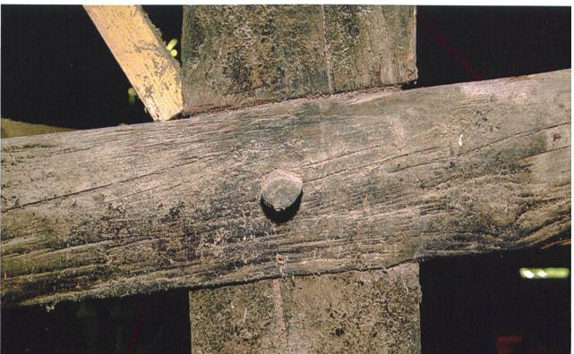
Das Prinzip der verschobenen Dachachse, der geplante und der schliesslich realisierte Abbund am Beispiel von Binder D (vlnr). laufenden (Langbänder), die die zentrale Firstsäule (Hochstud) vertreben sollen, sonst am gleichen Punkt auf dieser auftreffen würden und so nicht stark genüg verbunden werden könnten. Diese Verbindung ist aber in Anbetracht der Kräfte, die etwa bei Sturm auf eine derart grosse Dachfläche wirken können, eminent wichtig.
