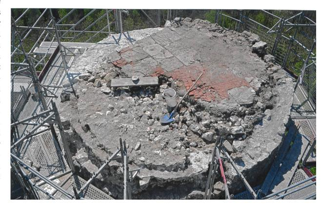
Die mächtigen Mauerkronen von Schildmauer und Hexenturm wurden mit grossen Kalksteinplatten geschützt (Jakob Obrecht). Schildmauer gesichert, indem an der Innen- wie Aussenseite Ausbrüche geschlossen und das Mauerwerk verfugt wurden. Während es sich bei der Schale an der Innenseite um eine etwa 70 Zentimeter breite, sekundär vorgeblendete Verstärkung handelt, die bei früheren Sanierungen weitgehend erneuert oder so umfangreich repariert wurde,
