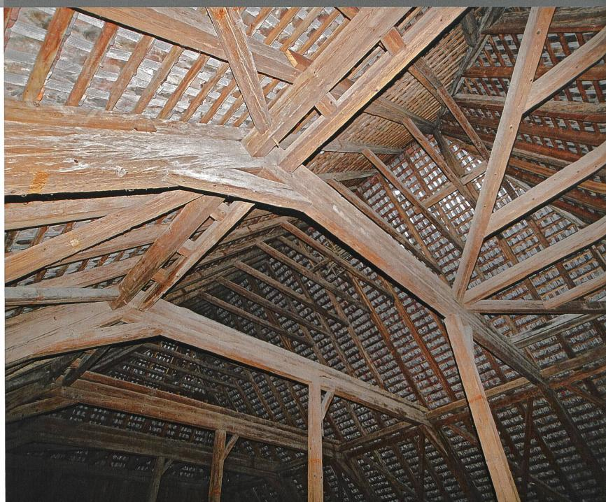
Augst, Hauptstrasse 25. Die Rösslischeune zeichnet sich durch eine moderne Stuhlkonstruktion und einen riesigen Lagerraum aus.
