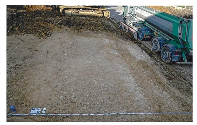
Schnitt durch den Strassenkörper, der von einer massiven Schicht aus Gehängelehm überlagert wird. Blick gegen Süden. Unter dem Strassenkoffer zeigt eine dunkle Lehmschicht mit Holzkohlefragmenten dessen Bauniveau an. Der Bereich des zukünftigen Verlaufs wurde dabei vor dem Aufkoffern mit Kies horizontal ausplaniert. Die Radiokarbon-Analyse eines Kohlestücks ergab ein Alter am Beginn der jüngeren Eisenzeit, zwischen 400 und 200 v. Chr.
