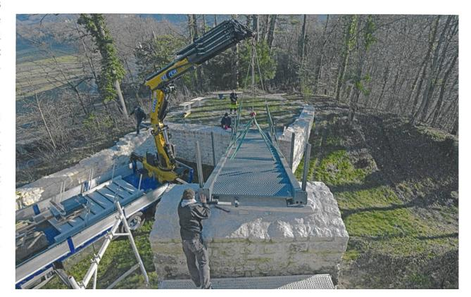
Sicherung der Flankenmauer beim inneren Tor. Das Schutzdach ermöglicht das Arbeiten auch bei Regenwetter (Jakob Obrecht). Kronenabdeckung der Schildmauer abgeklärt. Nach der Prüfung verschiedener Varianten mit Bleiplatten, Kupferblech oder der Erneuerung des bisherigen, schadhaft gewordenen Zementüberzugs entschied man sich für eine gemauerte Mauerkrone.
