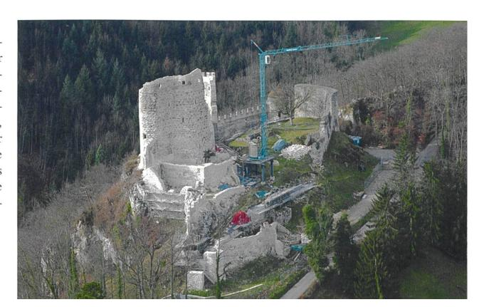
Auf den Zinnen der südlichen Umfassungsmauer werden die vorgefertigten Abdeckungen montiert (Jakob Obrecht). gewährleistet. Die Abdeckungen besitzen an der Maueraussenseite einen Überstand, der bewirkt, dass das Regenwasser nun nicht mehr direkt über das Mauerwerk abläuft, sondern vor der Mauer abtropft oder bei Wind grossflächig verteilt wird. Damit konzentriert sich das Wasser nun nicht
