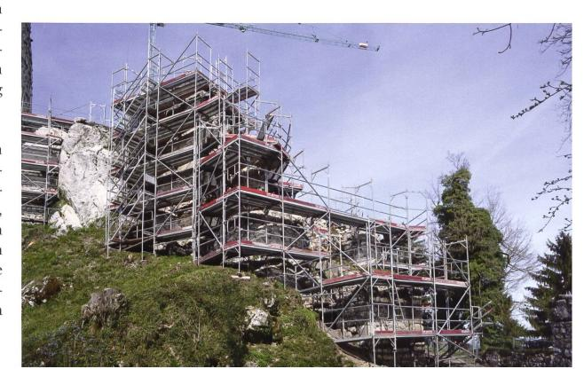
Auf einer Freifläche im südlichen Anbau der «Neuen Behausung» wird eine Abdichtungsmatte eingebracht. An der nördlichen und an der südöstlichen Umfassungsmauer stellte man bei der bauarchäologischen Untersuchung Reste von Zinnen fest, die in Teilbereichen in ihrer ursprünglichen Form, mit einer Abdeckung aus Dachziegeln, wieder hergerichtet wurden.
