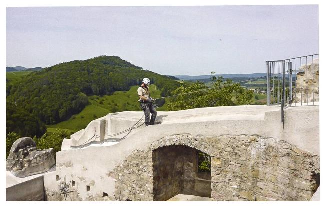
Weiter ist darauf zu achten, dass alle verwendeten Baumaterialien eine höchstmögliche Frostsicherheit besitzen. Andernfalls drohen Schäden durch die Sprengkraft gefrierenden Wassers. Aber auch bei optimaler Ausführung der Arbeiten ist damit zu rechnen, dass es mit der Zeit zu Schäden kommt, verursacht beispielsweise durch kleine Risse, die durch die unterschiedliche Ausdehnung der einzelnen Baustoffe bei Temperaturschwankungen entstehen.
