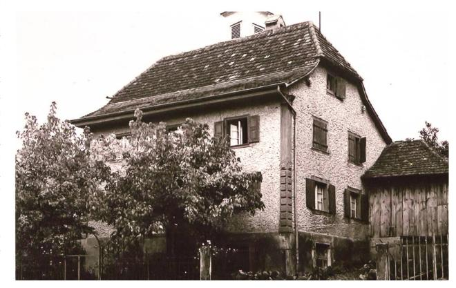
An der Traffassade zeigt sich, wie die Dachbalken höher gelegt wurden. Gebäudes an seinem Ursprungsort bleiben aus Kapazitätsgründen unerforscht. Das komplett aus Eichenholz gefertigte Gerüst datiert aufgrund seines geschossweisen Abbunds und der Holzbearbeitung mit Breitbeil frühestens in das spätere 17. respektive frühe 18. Jahrhundert. Da Hagenthal jedoch 1633 im Dreissigjährigen Krieg verwüstet
