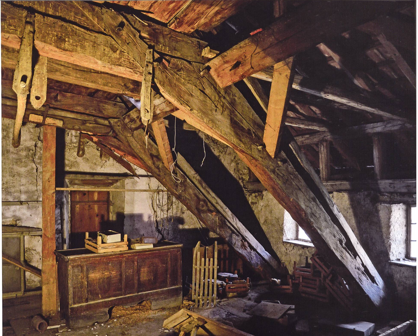
Oltingen, Schafmattstrasse 69. Blick in den Dachstock mit dem jahringdatierten Stuhl von 1558/59.
