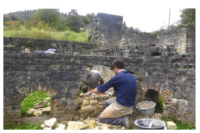
Vor den Sicherungen wurde der gesamte Bestand differenziert nach römischem Originalbestand und rekonstruiertem Mauerwerk aufgenommen. Hilfreich war hierbei, dass man – wie früher vielfach üblich – die Oberkante des originalen Mauerwerks mit Eternitplättchen markiert hatte. Es zeigte sich, dass bei einem heute über dem Bodenniveau sichtbaren Mauerbestand von insgesamt 136 m³ der Bestand an originalem antikem Mauerwerk lediglich 36 m³ beziehungsweise rund 26% umfasst.
