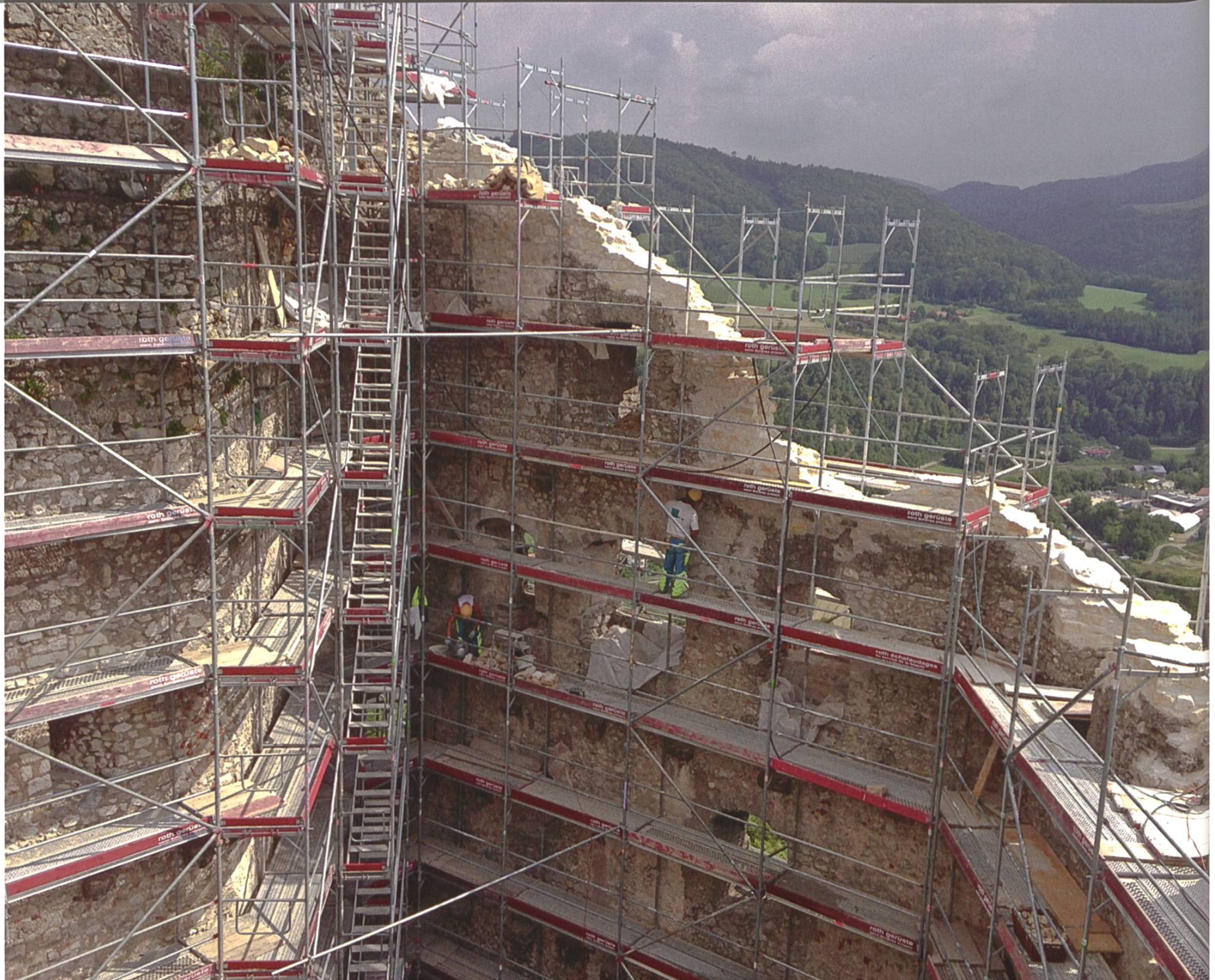
Ruine Pfeffingen. Blick auf die eingerüstete Ostmauer des Wohnturms. Am noch frischen hellen Mörtel sind die erneuerten Partien der Mauerkrone deutlich zu erkennen.
