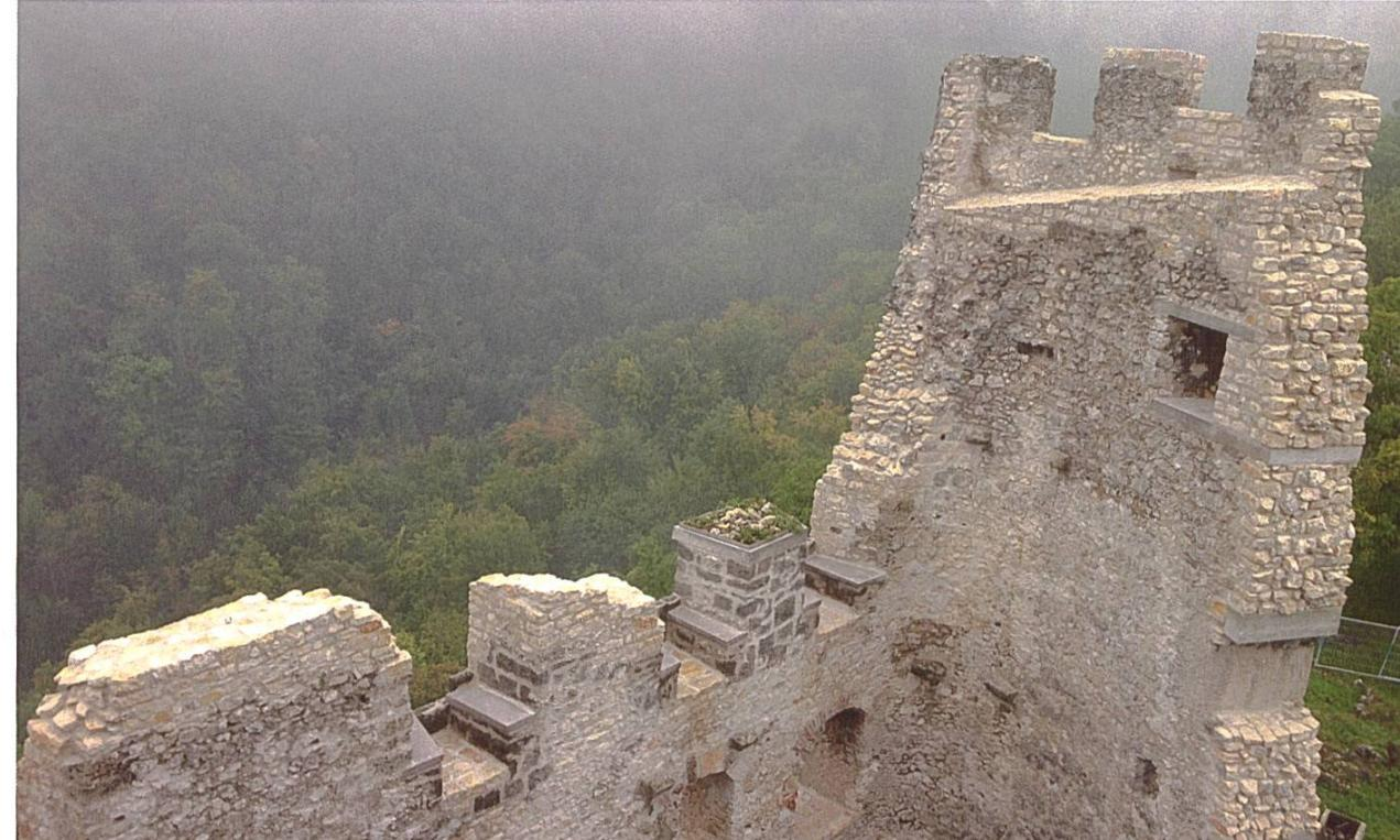
Farnsburg. Die Schildmauer von Süden. An der rechten Mauerhälfte angebrachte Anker und Spangen sichern neu das Mauerwerk.
