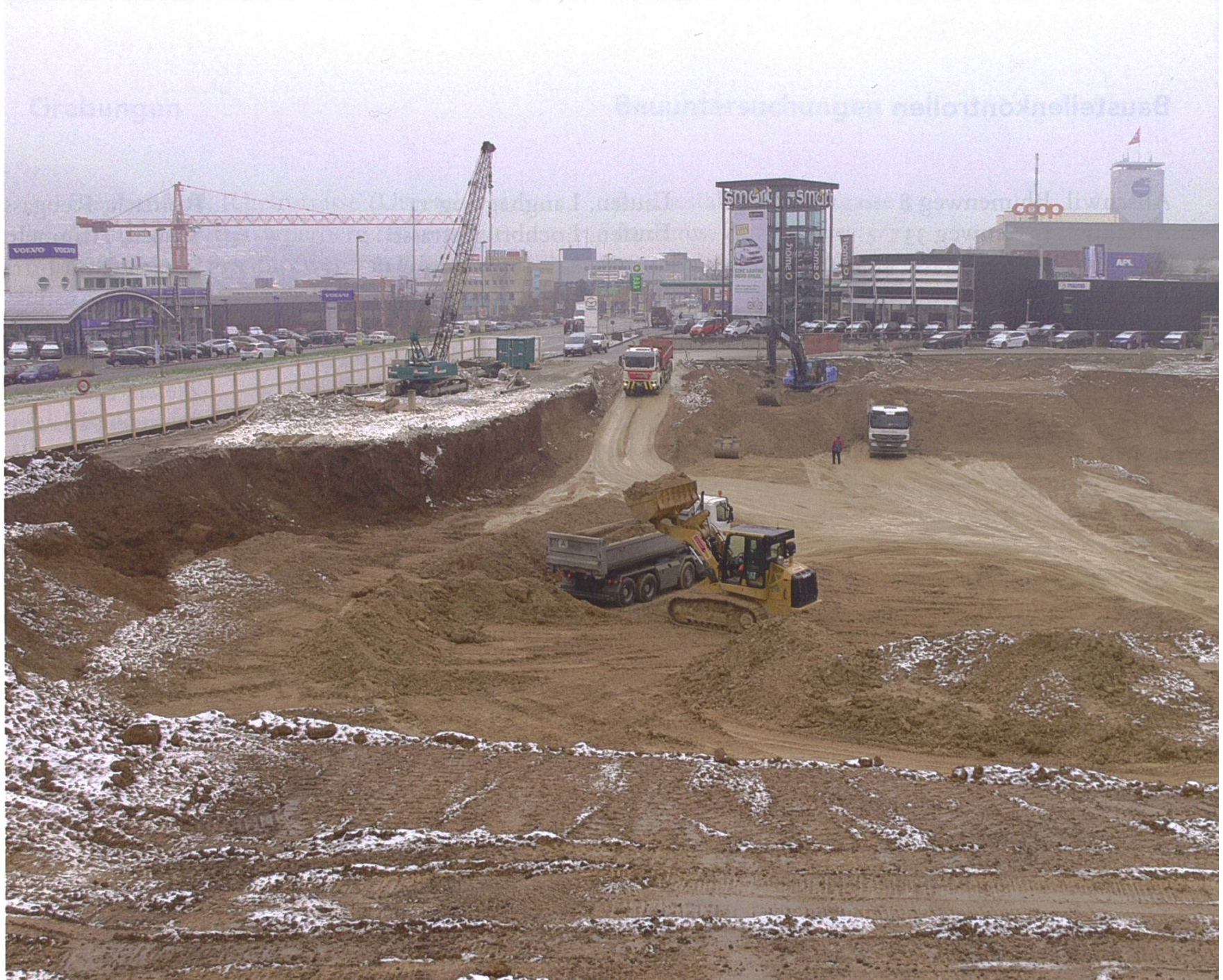
Frenkendorf, Rheinstrasse. Die Fundstelle befindet sich im Bereich der steilen Böschung auf der linken Bildseite, nahe der Rheinstrasse. Die neue Grabungssaison begann nasskalt ...
