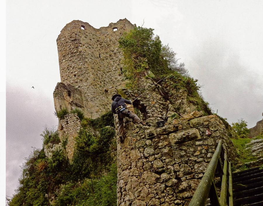
Ruine Pfeffingen. Die Sicherungsarbeiten am Südturm des Osttores wurden von spezialisierten «Klettermaurern» durchgeführt (Foto Freie Bauhütte).
