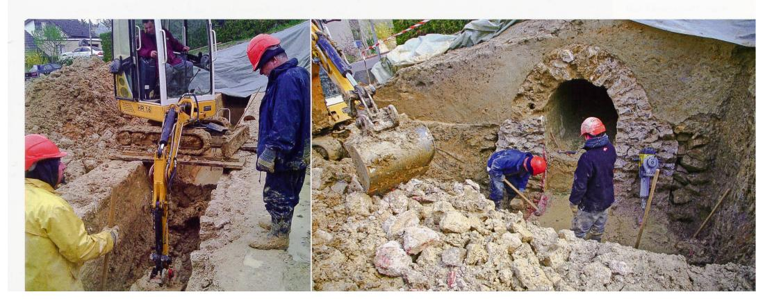
Sarah Hänggi dokumentiert ganz genau, wie die Leitung seinerzeit überdeckt worden war. liegende Schicht besteht aus einem Lehm, der – im Wasser gelöst – im Laufe der Jahrhunderte durch kleinste Spalten und Öffnungen des Gewölbes eindrang und sich ablagerte. Die starke Versinterung des Gewölbes zeigt, dass hier viel Wasser von oben durch das Gewölbe eingesickert ist.
