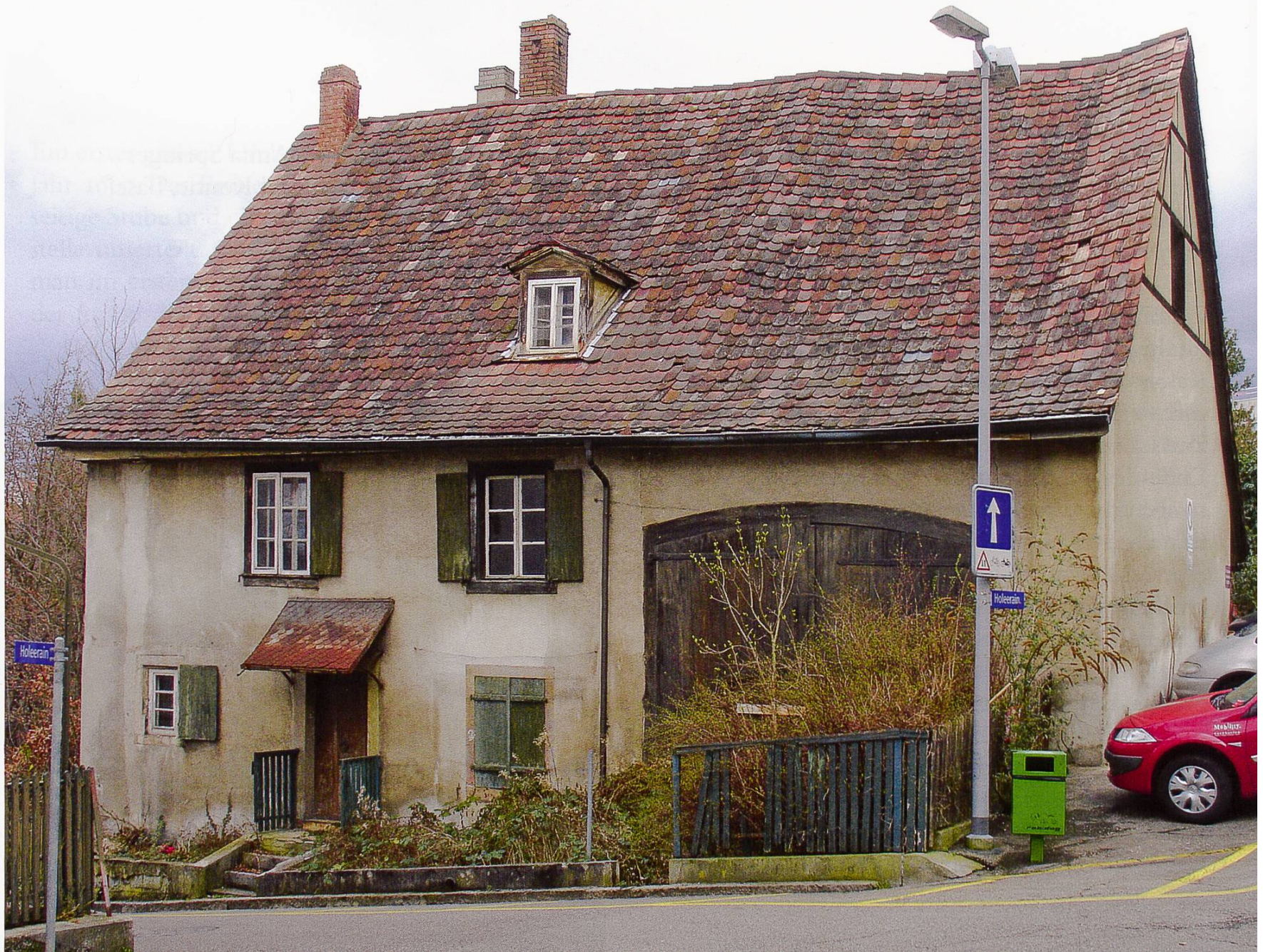
Binningen, Holee 42. Ansicht der strassen- seitigen, gegen das Herrenhaus gerichte- ten Trauffassade des Sutterhauses. Das Fachwerk ist über- putzt.
