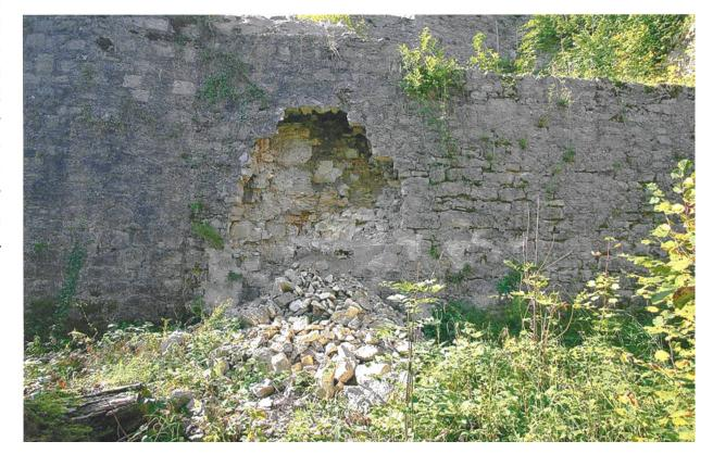
Die mächtige Schildmauer weist viele Ausbrüche auf, deren Entwicklung über die Jahre genau verfolgt wird. Hier ist nun ein nahezu kompletter Neubau dieses Mauerabschnitts erforderlich, wobei nach einem sorgsamen Abbau des zerstörten Steinwerks zuerst abgeklärt werden muss, ob und in welchem Ausmass noch originales Mauerwerk erhalten werden kann. Bei den Reparaturarbeiten ist grosser Wert auf die
