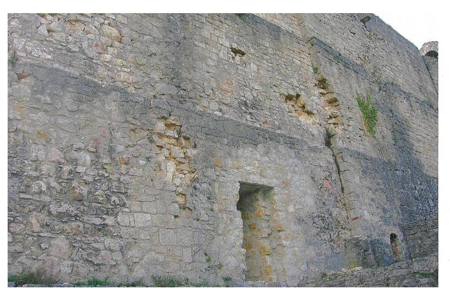
Um sich einen Überblick zu verschaffen, wurden sämtliche Schäden auf der Farnsburg neu erfasst. Dabei zeigte sich, dass sich an der Innenseite der Schildmauer verschiedene Ausbrüche der Mauerschale stark vergrössert haben. Am Mauerfuss liegen an verschiedenen Stellen denn auch frisch herunter gefallene Steine. Wegen dieser Steinschlaggefahr musste der unmittelbare Bereich hinter der Schildmauer abgesperrt werden. Auch in anderen
