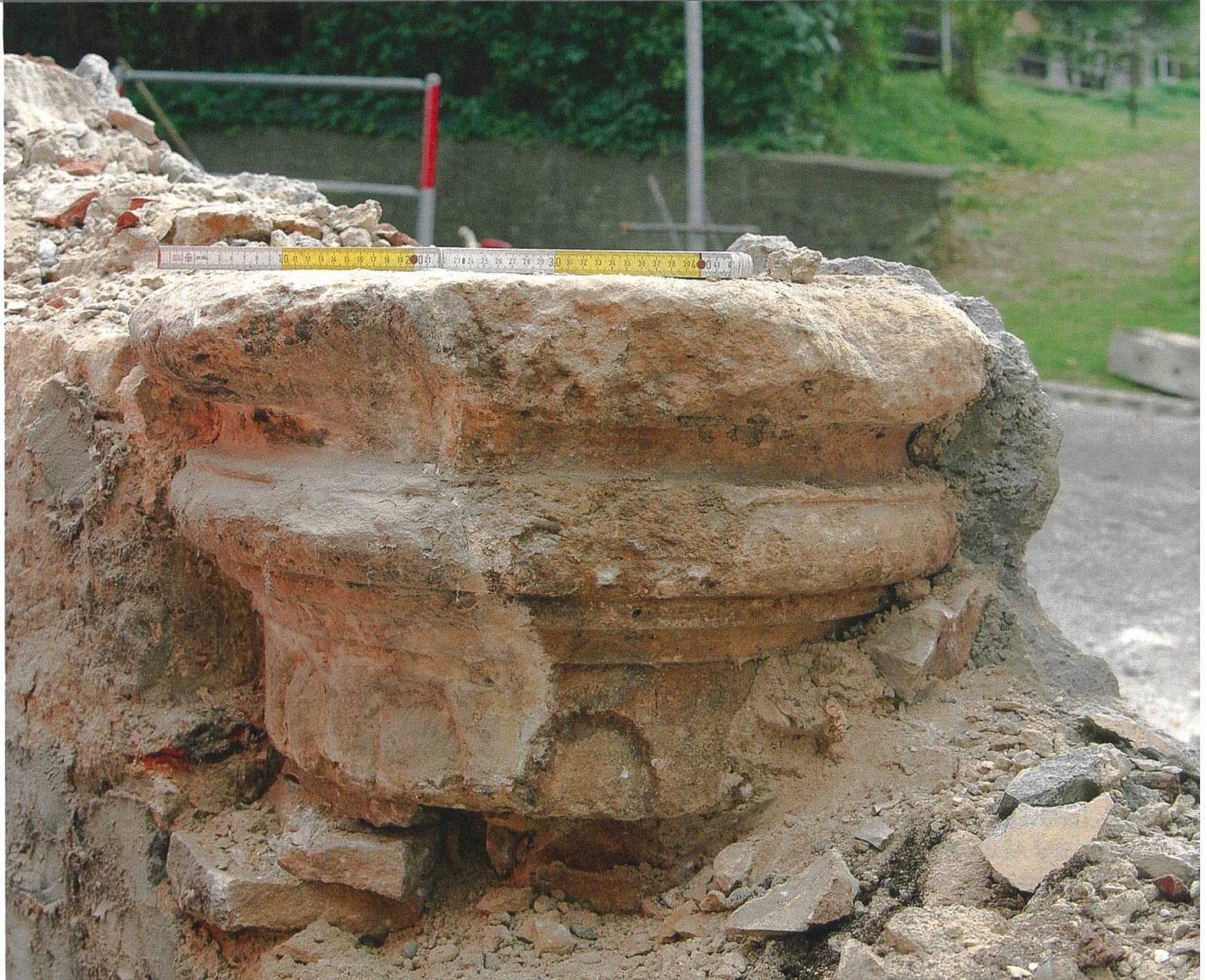
Im Waschhaus an der Hauptstrasse 66 in Pratteln war als Absatz für eine Lichtnische eine römische Säulenbasis – verkehrt herum – eingemauert.
