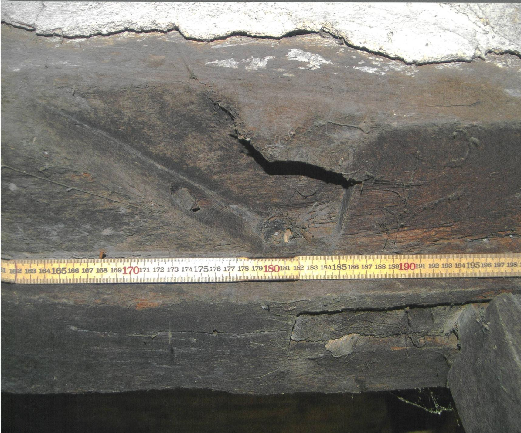
Untersicht des Durchganges in der internen Kellermauer, möglicherweise spätmittelalterlich. Der eichene Türpfosten wurde zwecks Verbreiterung des Zugangs in den Gewölbekeller nach aussen versetzt. Die Vertiefung im Sturzbalken ermöglichte das Einschieben der Türangel. Ein durchgeschobener Holznagel fixierte diese.
