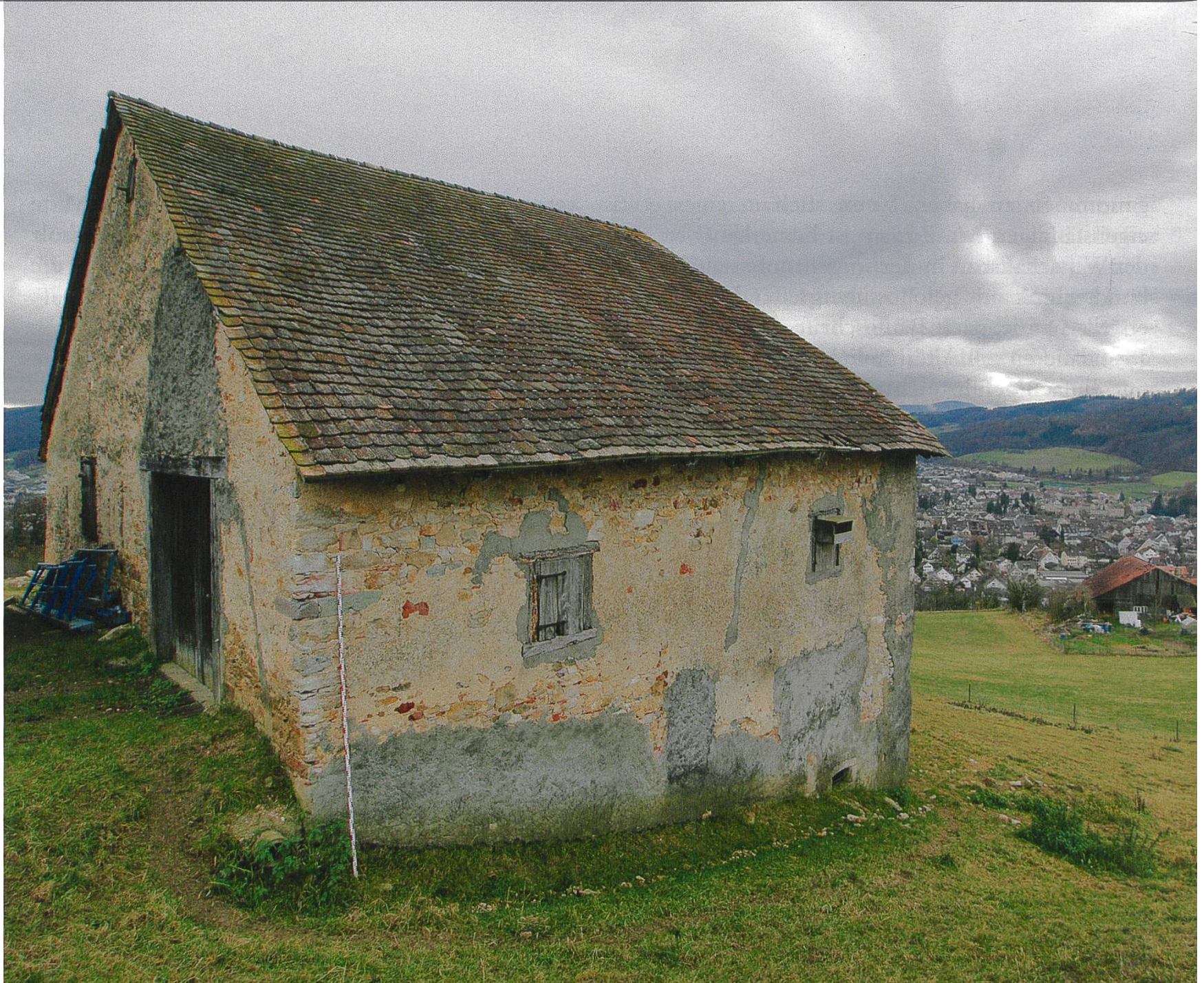
Sissach, Kienberg. Die Feldscheune mit hangseitiger Einfahrt. Blick nach Südwesten Richtung Sissach (im Hintergrund).
