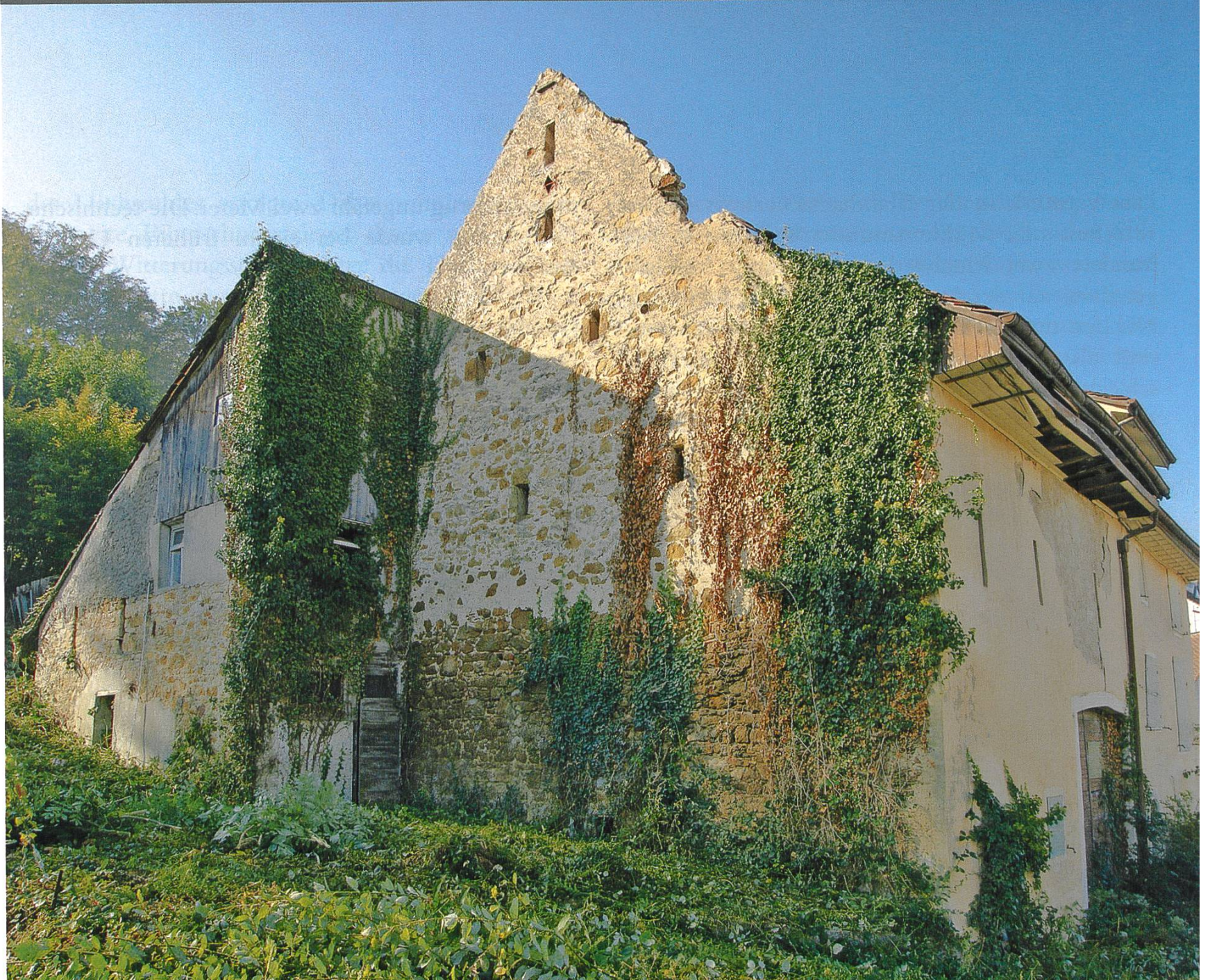
Pratteln, Hauptstrasse 66, Blick nach Südwesten. Giebel der Ökonomie mit später angebautem Schopf mit Pultdach.
