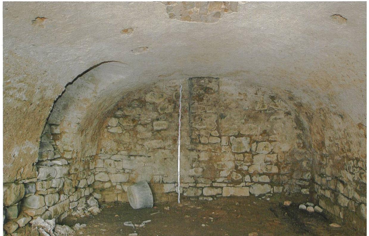
**Die Laibung des Tores besteht vorwiegend aus Kalksteinspolien unterschiedlichster Bearbeitung.**
