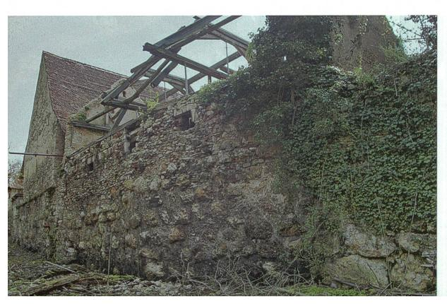
der Leitung der kantonalen Denkmalpflege und des Architekturbüros Schwob & Suter die südliche, bauchende Riegelfassade durch die Firma Gebr. Sekinger AG gesichert und begradigt. Die Nordfassade musste rekonstruiert werden. Der Dachstuhl wurde mit neuen und noch verwendbaren alten Balken wieder aufgerichtet. Zwei Betonsilos im Innern des Schopfes hat man soweit als möglich entfernt.
