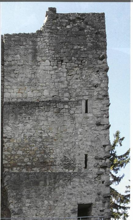
Durch die Fotoentzerrung können Objekte – hier die Schildmauer der Farnsburg – massstabsgerecht dokumentiert werden.
