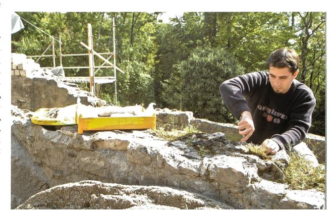
Am Westzwinger wird der zerstörte äussere Mauermantel mit frostbeständigen Steinen neu aufgebaut. Zunächst ging es an die Mauern im Westen und Süden der Unterburg. Das Konzept sah vor, die originale Bausubstanz – in diesem Fall das zu Beginn des 15. Jahrhunderts entstandene Mauerwerk mit den bis 1798 erfolgten Reparaturen – so weit als möglich zu erhalten und zu konservieren. Beim
