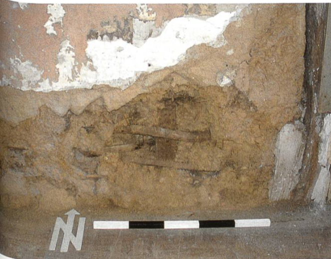
Allschwil, Schönenbuchstrasse 17, interne Wand im Erdgeschoss. Flechtwerk mit Lehmfüllung. Datierung 18. Jahrhundert.
