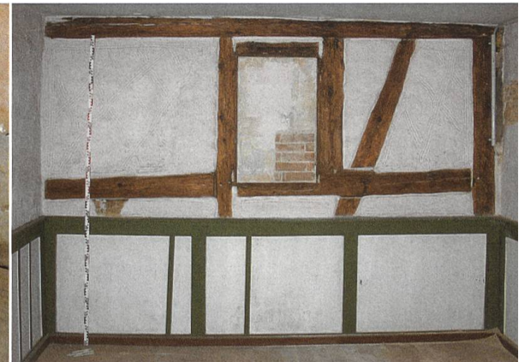
Binningen, Schlüsselgasse 4, Aussenwand, Innenansicht mit geometrischer Fingerstrich-Verzierung. Datierung 18. Jahrhundert, Raumgestaltung zweite Hälfte 19. Jahrhundert.
