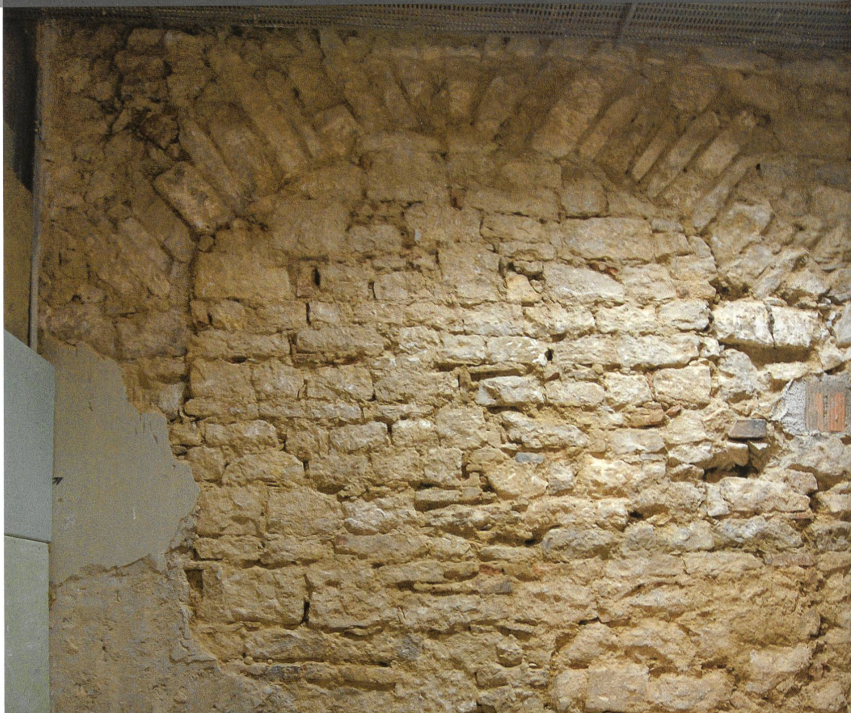
Liestal, Regierungsgebäude. Ansicht der Aussen- seite der vermauert Toröffnung mit Blick vom Anbau in Richtung Südwesten.
