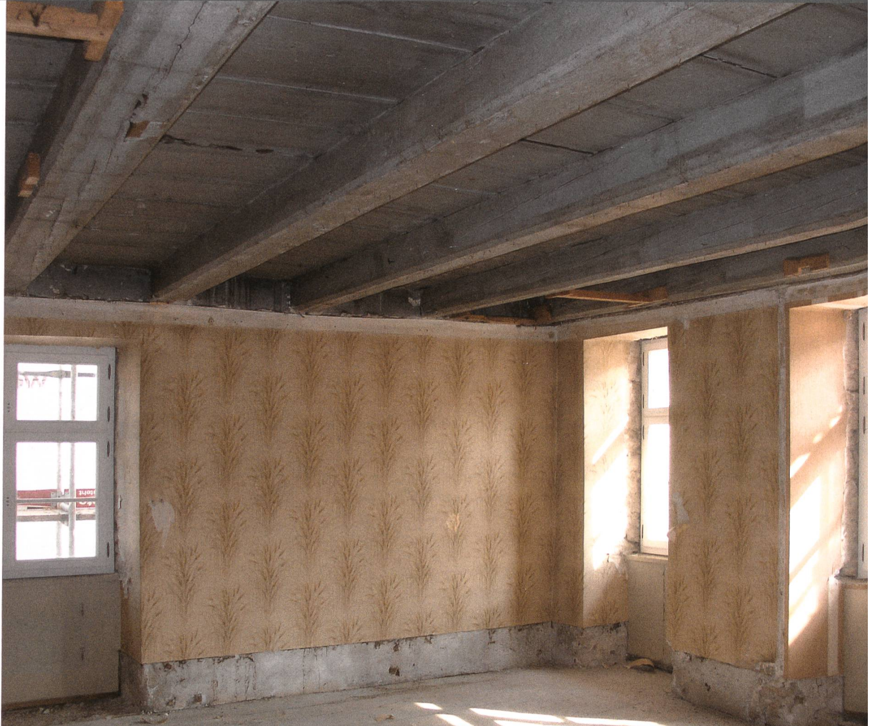
Arisdorf, Gasthaus Rössli. Das grosszügige Piano nobile im ersten Obergeschoss mit gefasten Deckenbalken.
