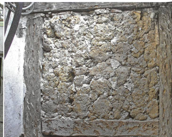
Oberwil, Hauptstrasse 36, interne Wand. Zur besseren Haftung des abschliessenden Mörtelputzes wurden in die Oberflächen der Lehmklumpen Löcher eingestochen.
