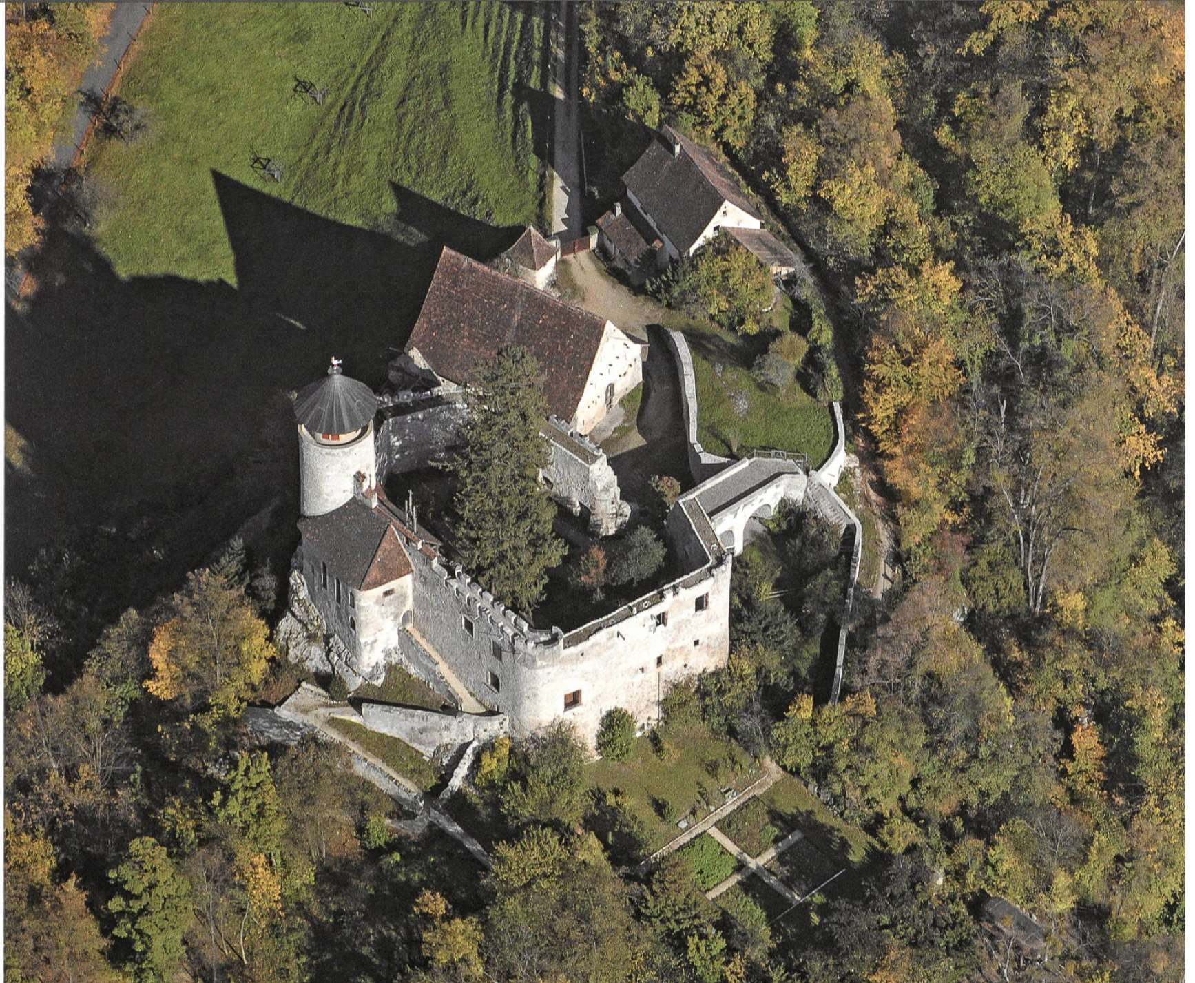
Luftaufnahme von Burg und Hofgut Birseck nach Abschluss der Restaurierungsarbeiten (Patrick Nagy, Kantons- archäologie Zürich).
