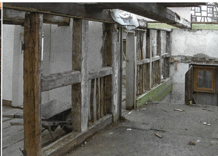
Oberwil, Hauptstrasse 36, interne Wand im Erdgeschoss und ersten Obergeschoss. Sie trennte den Gang von den anschliessenden Kammern. Datierung 18. Jahrhundert.
