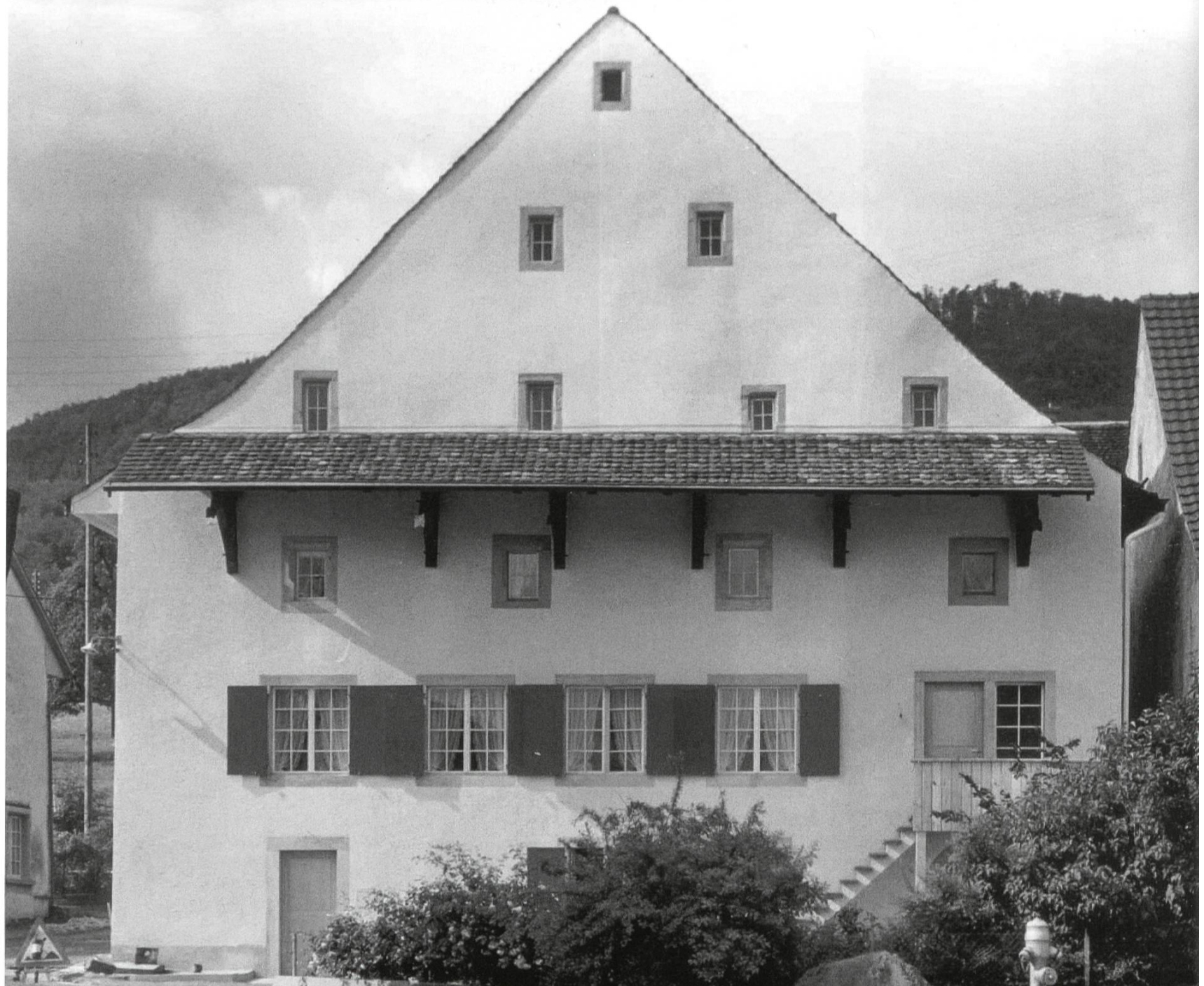
Känerkinden, Ueligasse. Die Nordfassade, Schauseite des prominenten Gebäudes, im Jahre 1966.
