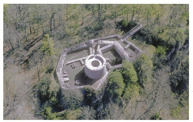
bis in die Ruine vorfahren konnte. Allerdings musste das für die Reinigung der Mauerkronen und die Anmischung des Mörtels benötigte Wasser von einem mobilen Tank auf Böckter Seite über eine 200 Meter lange Leitung mit 40 Metern Höhendifferenz heraufgepumpt werden.
