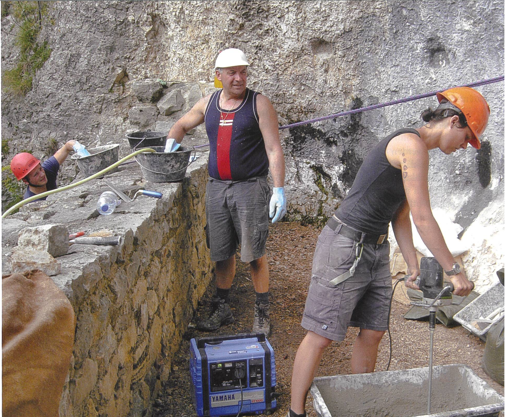
Eptingen, Riedfluh. Johannes Häusermann, Alessandro Mastro- vincenzo und Sarah Hänggi (vlnr) beim Ausflicken von Mauerwerk und Mischen des Spezialmörtels.
