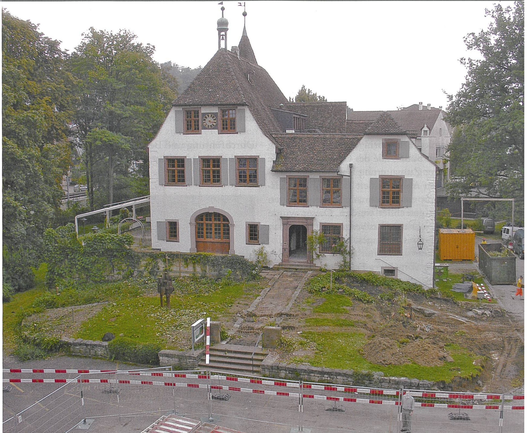
Binningen, Schloss. Der Eingangsbereich auf der Nordseite des Schlosses zu Beginn der Umgestaltungs- arbeiten.
