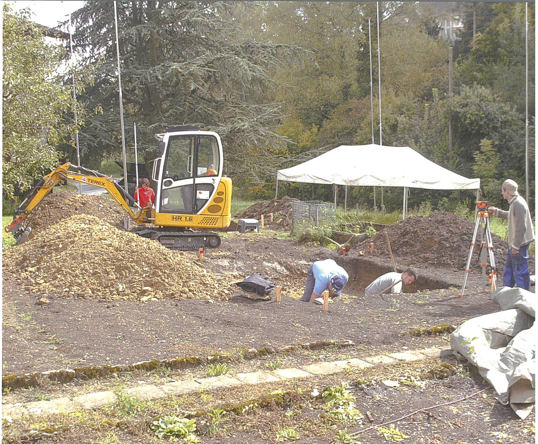
Liestal, Goldbrunnenstrasse. Bei den Sondier- grabungen lieferte der betriebseigene Kleinbagger wertvolle Dienste.
