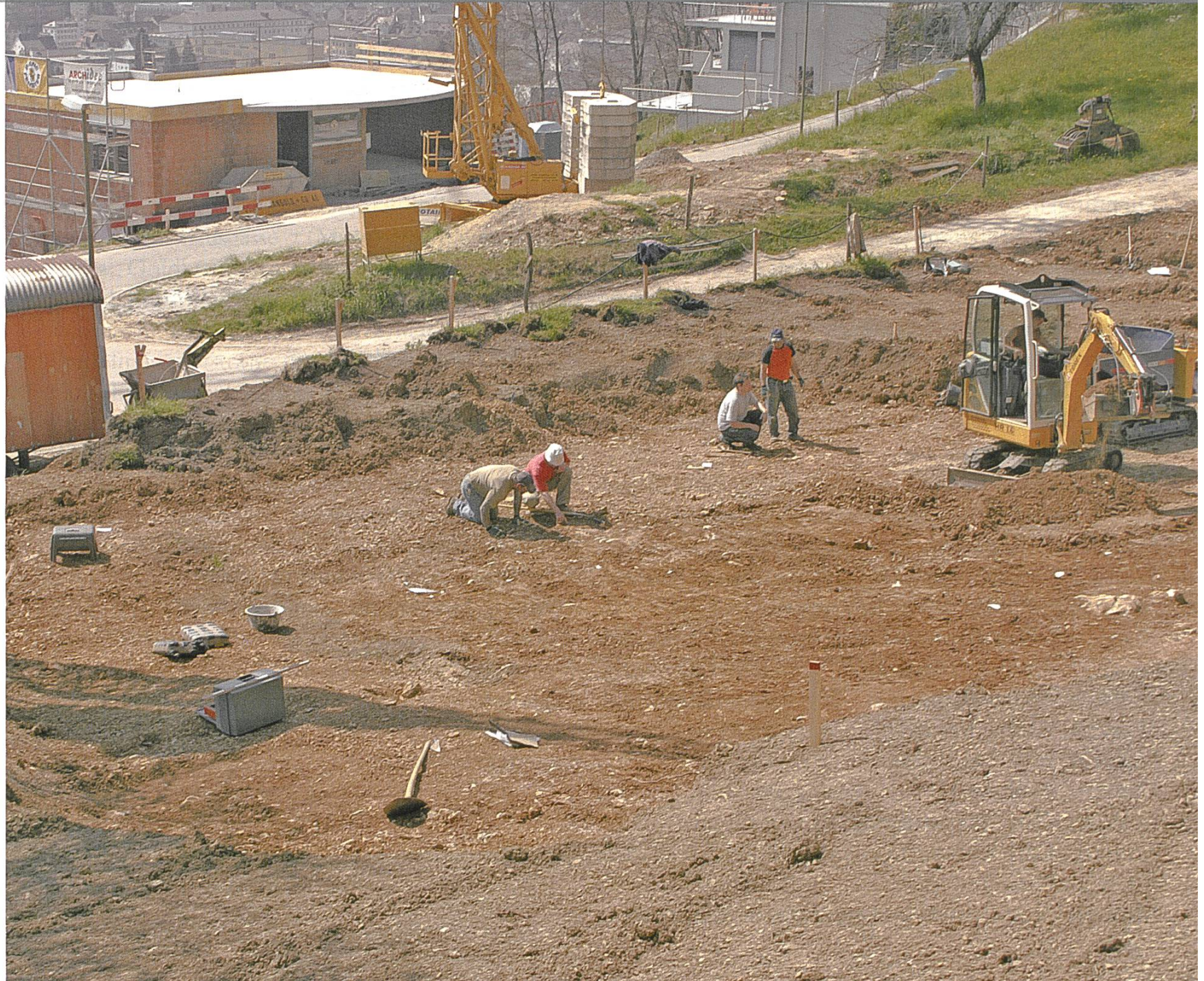
Liestal, Hurlistrasse. Das Team beim Freilegen der Kalk- schutttoberfläche auf der Hangterrasse.
