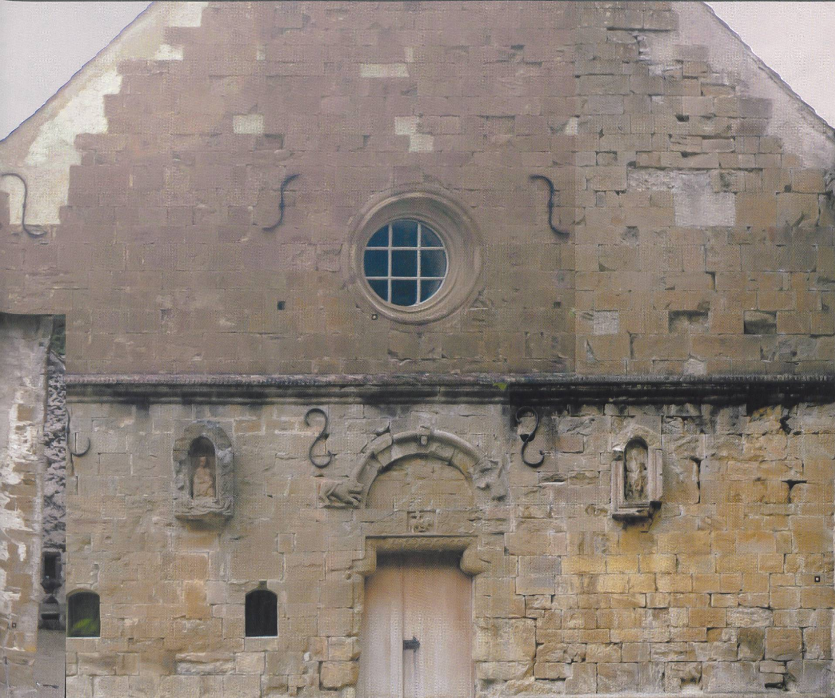
Entzerrte photogrammetrische Aufnahme der Westfassade der Klosterkirche (Institut für Vermessung und Geoinformation der FHNW).
