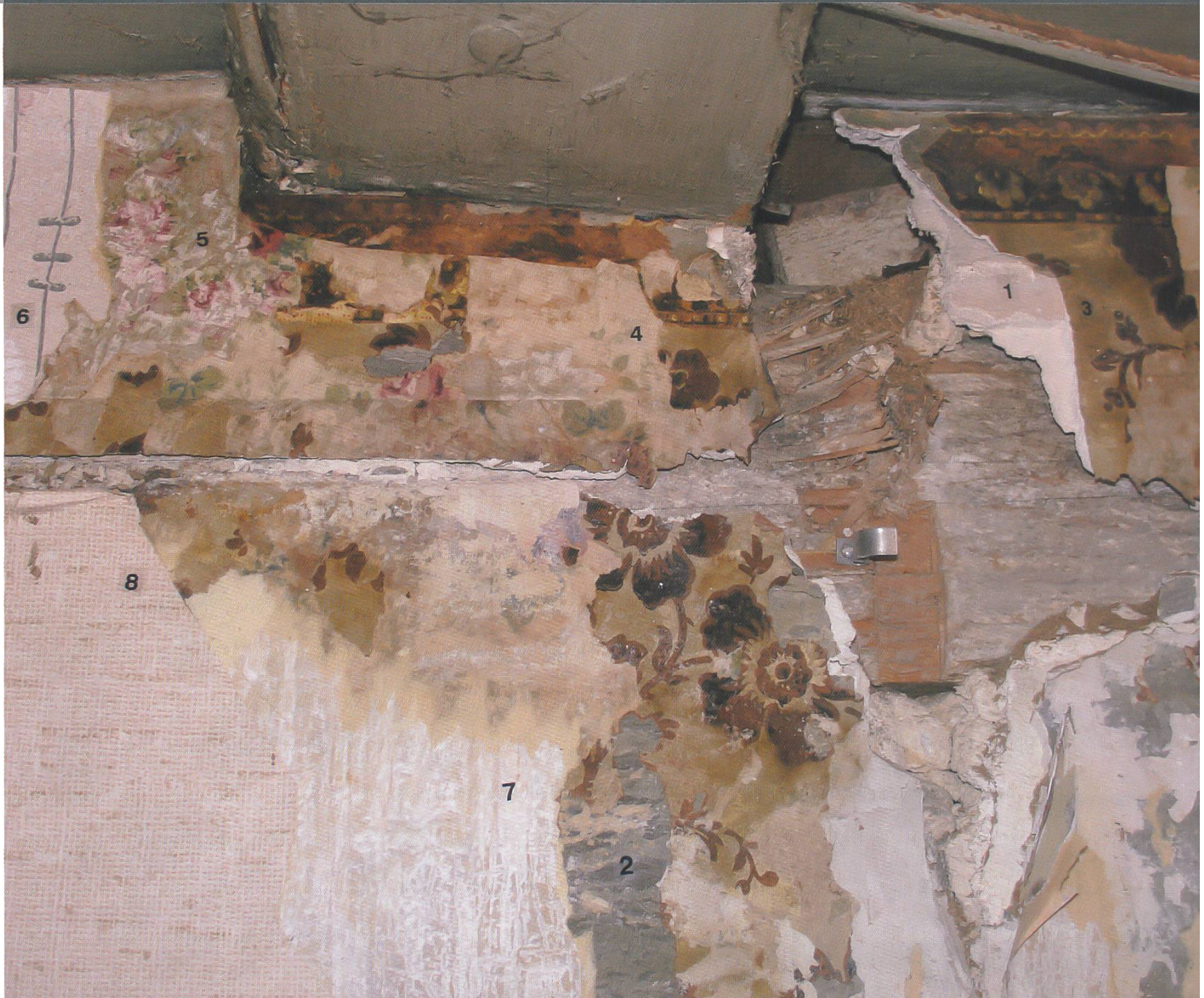
Tapeten. In der Stube im ersten Oberge- schoss liessen sich bis acht Farbanstriche und Tapetenfolgen des 19. Jahrhunderts nach- weisen.
