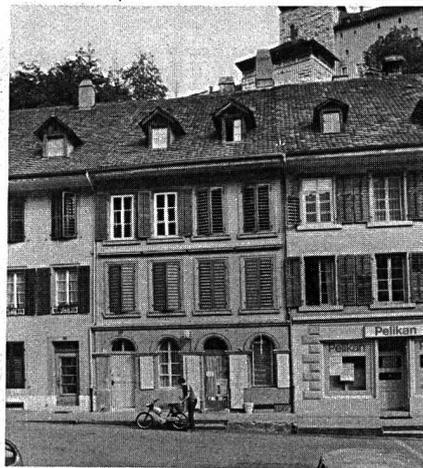
**BESCHREIBUNG** 3-geschossiger, verputzter Massivbau über Rechteckgrundriss (ca 7 m x 13 m),
