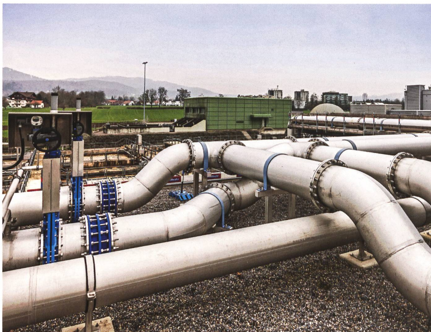
Zulaufleitungen in die Reaktorbecken
