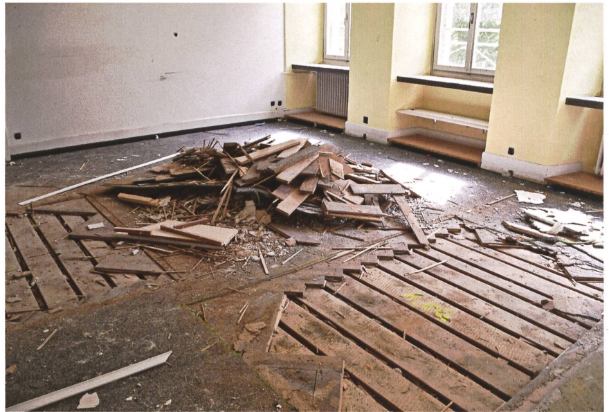
Sondierungen brachten Fischgrätböden und alte Stützbalken zum Vorschein.
