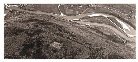
Luftaufnahme des Pumpspeicherkraftwerks mit der Druckleitung vom Maschinenhaus bis zum Speicherbecken auf dem Born, 1922
