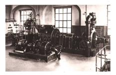
Hochzentrifugalpumpen zum Spitzenausgleich im Maschinenhaus des Pumpspeicherkraftwerks, 1904
