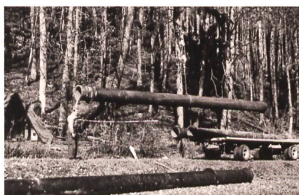
Abtransport der demontierten Druckleitung, Februar 1960
