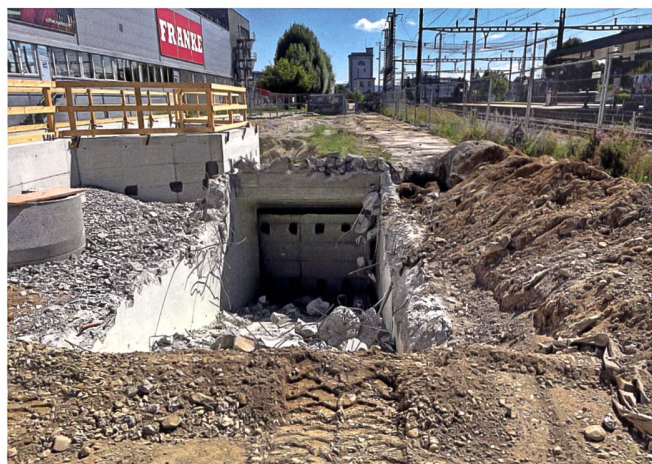
Abbruch alte Unterführung (September 2021).
