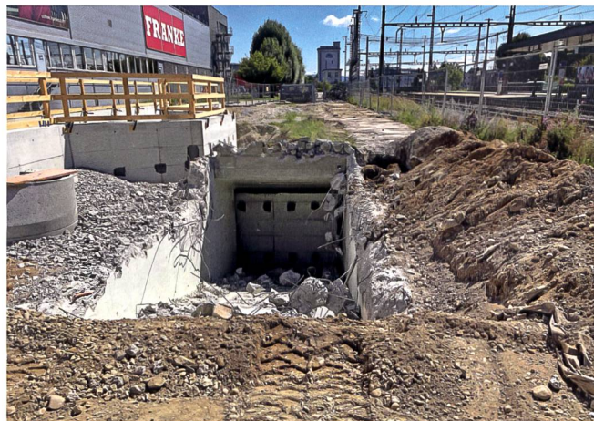
Abbruch alte Unterführung (September 2021).
