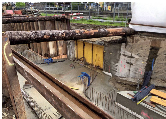
Anschluss an die Unterführung (Mai 2021).
