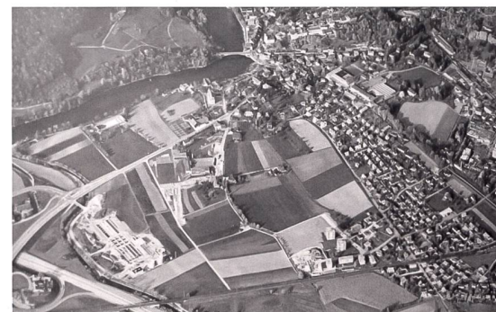
Aarburg Süd um 1970. Das Altersheim Falkenhof (unten Mitte) befindet sich im Bau. Foto ZT-Archiv
