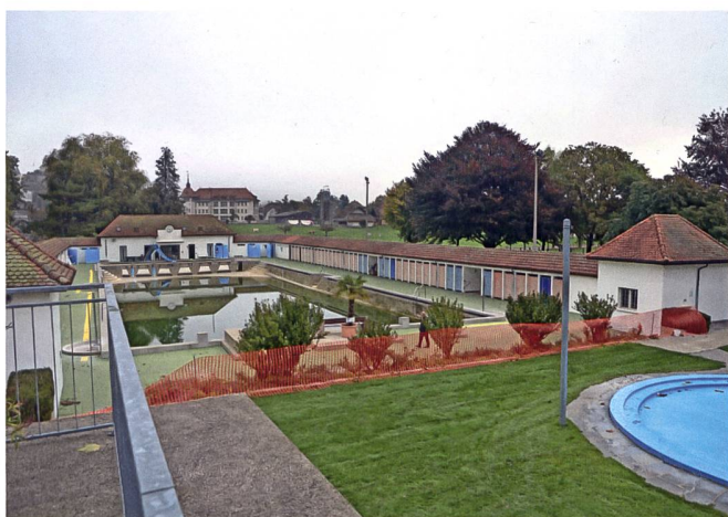
Das Freibad vor der Sanierung im Herbst 2020 ...
