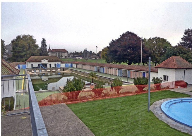
Das Freibad vor der Sanierung im Herbst 2020 ...
