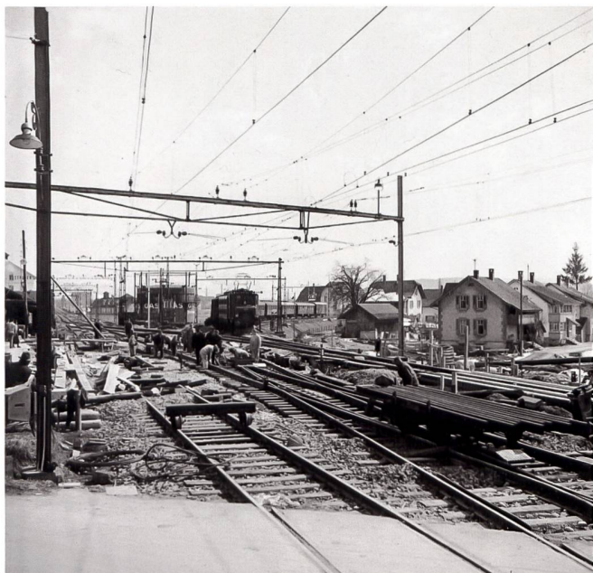
Wenige Tage nach der Unterzeichnung der Werkverträge wurde mit dem Bau begonnen. Foto Archiv SBB Historic
