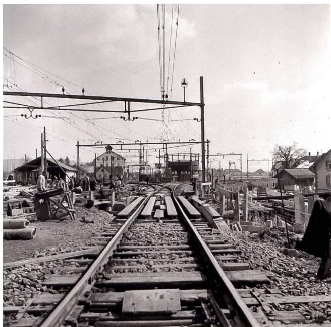
Zur Vereinfachung der Ausführung der Brückendecke wurden verschiedene provisorische Änderungen an der Gleisanlage notwendig. Foto Archiv SBB Historic
