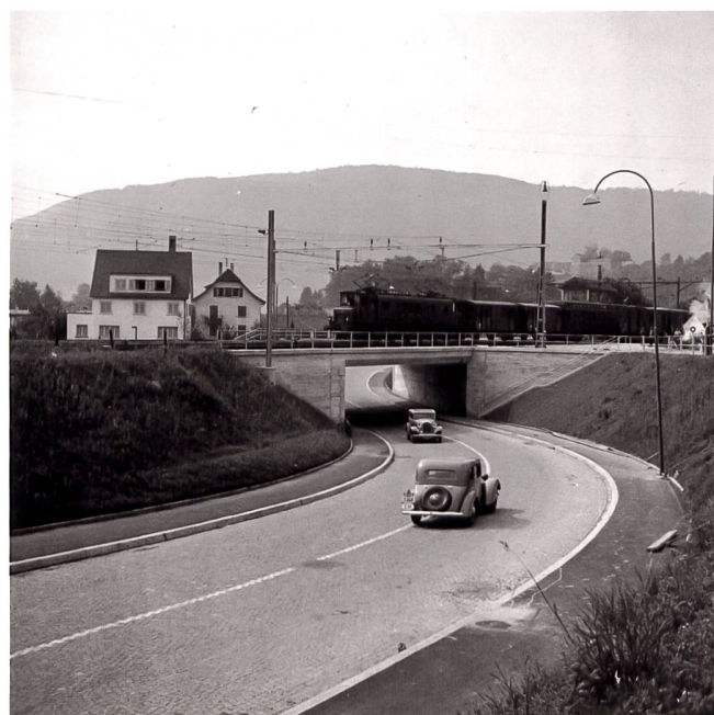
17. Juli 1939: Das Bauwerk ist vollendet, Fahrbahn und Trottoirs wurden dem Verkehr übergeben. Foto Archiv SBB Historic
