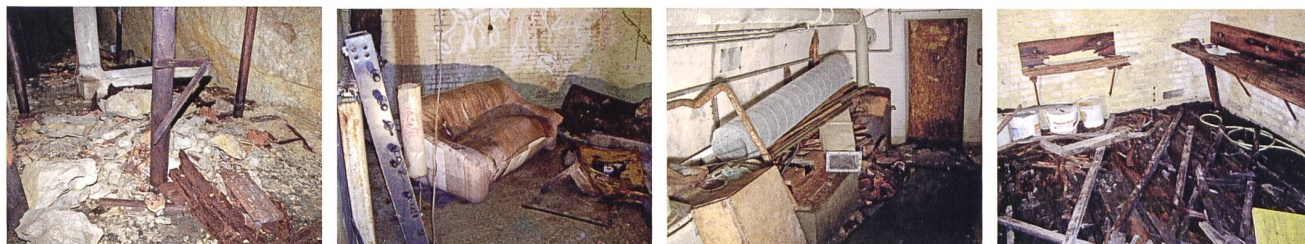
Als der Kommandoposten 2009 erstmals seit 24 Jahren geöffnet wurde, war er in einem desolaten Zustand. Fotos: Max Roth
