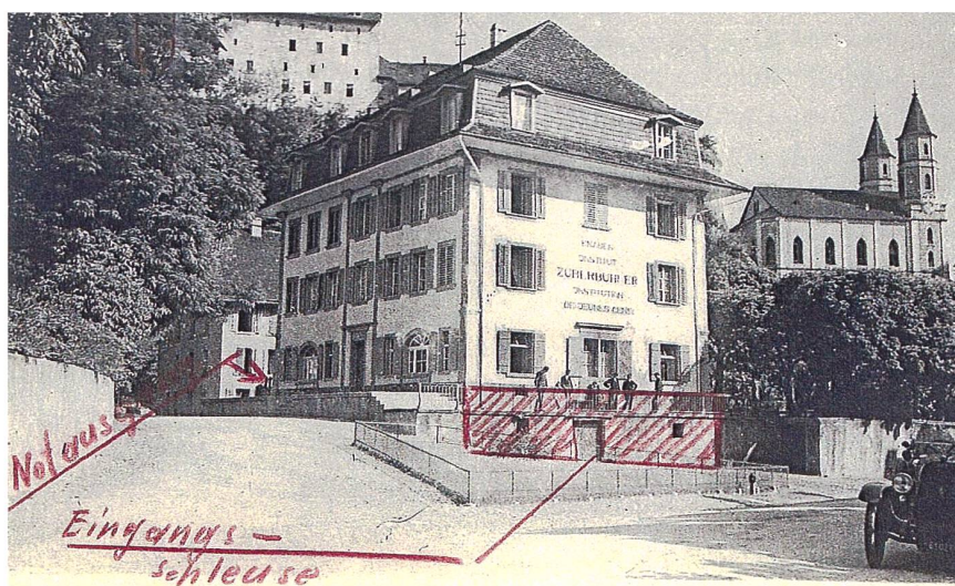
Im Keller des Institutes Zuberbühler wurde 1937 ein behelfsmässiger Schutzraum eingerichtet. Foto: Heimatmuseum Aarburg
