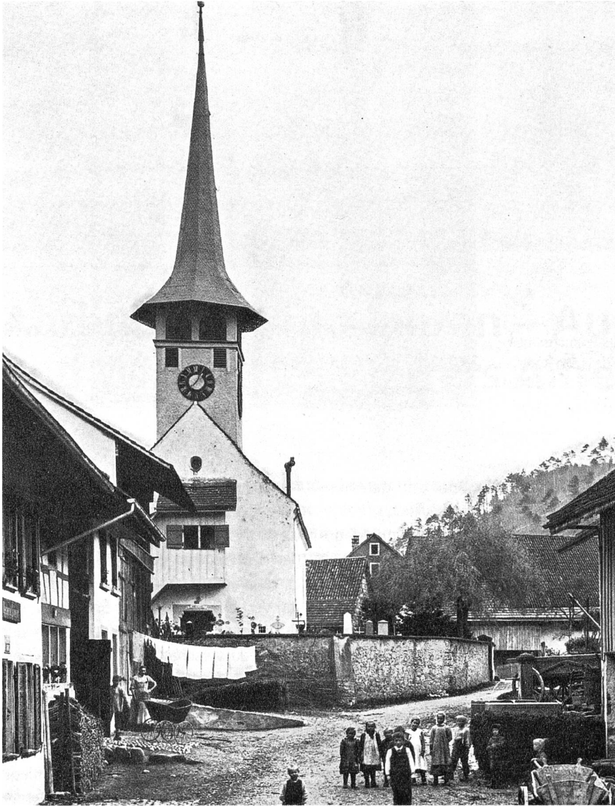
Kirche Pfungen im Oktober 1909, einen Monat nach Zimmermanns Wahl zum Pfarrer von Aarburg. Aus der Broschüre: Zur Renovation der Kirche Pfungen 1964/65. Foto: Kant. Hochbauamt Zürich
