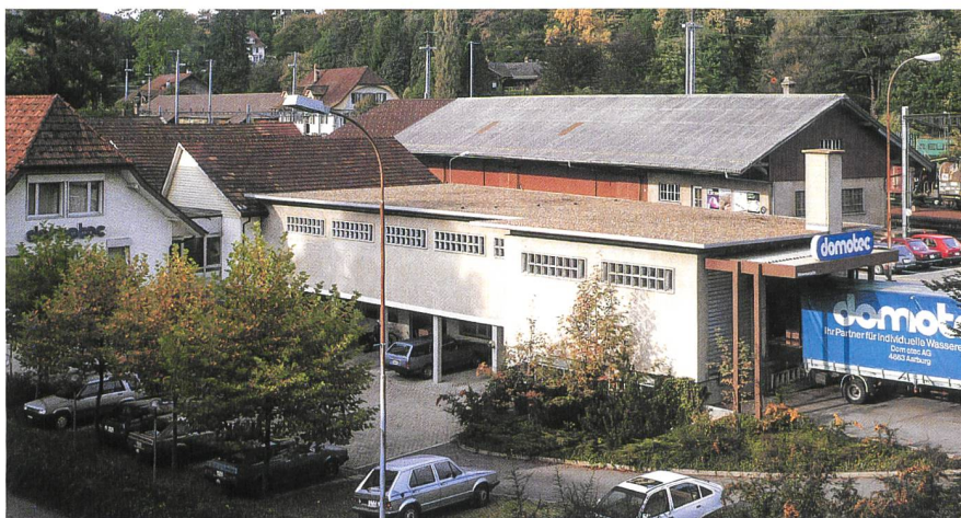
Von 1984 bis 1995 war Domotec beim Bahnhof Aarburg ansässig.
