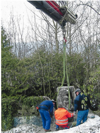
Der Faun wird aus dem Park der Villa Lindengut an den neuen Standort transportiert.
