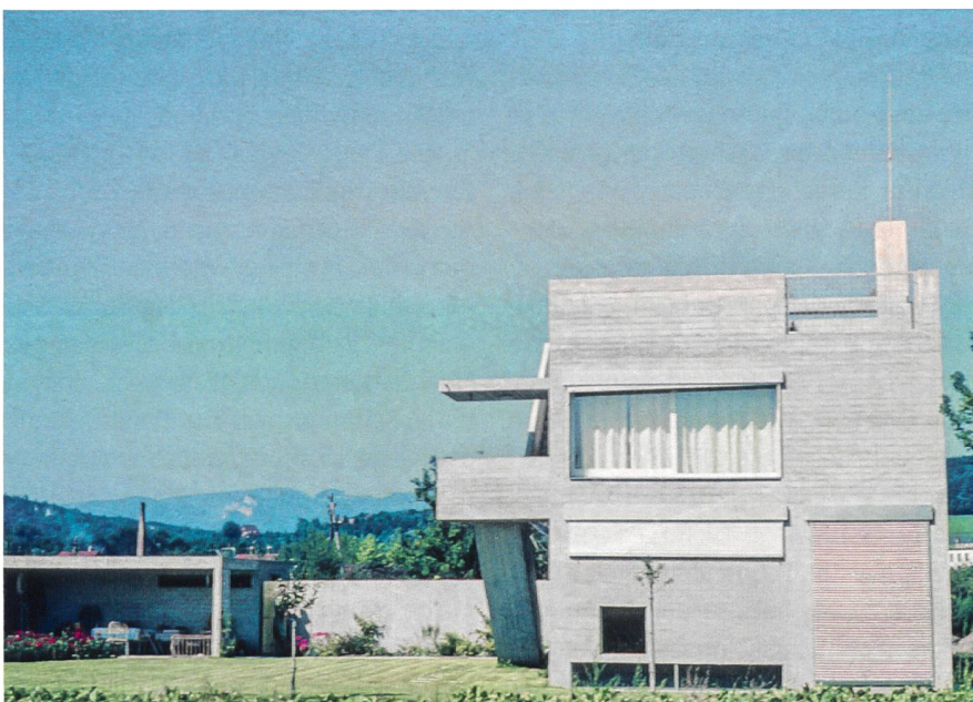
Südfassade. Links die zur Garage zugehörige Gartenhalle. (Historische Fotografie: ©Archiv Atelier 5)
